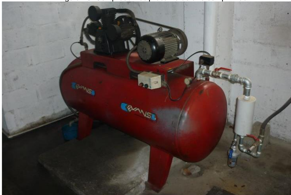
Figura 46. Compresor recíprocante de aire comprimido
