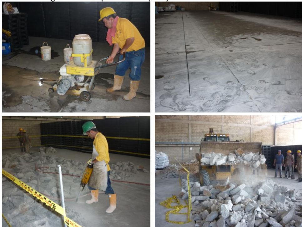
Figura 73. Rompimiento del piso y remoción de escombros
