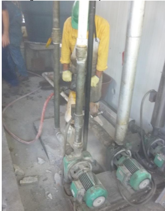
Figura 117. Desmontaje de bombas
