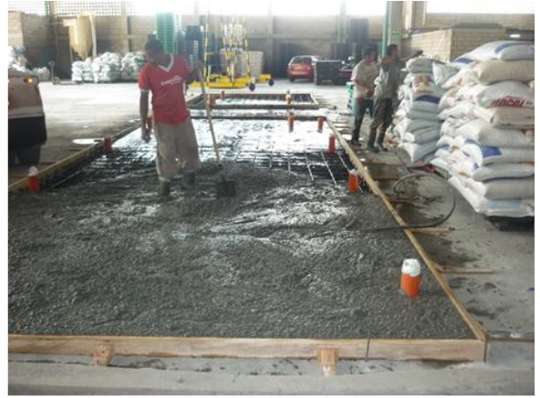
Figura 76. Fundición del concreto
