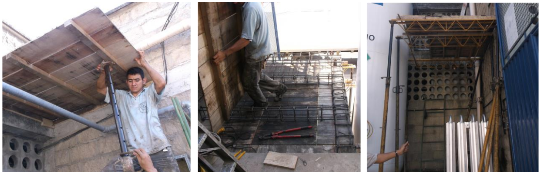
Figura 122. Instalación nueva torre de enfriamiento
