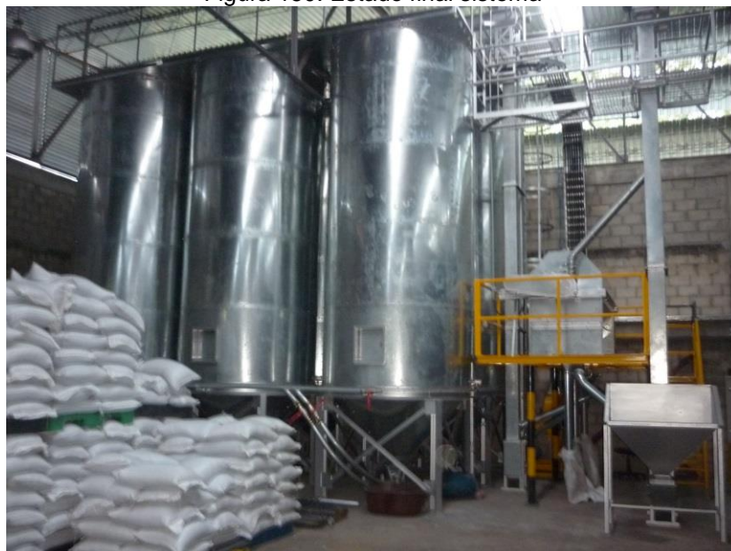
Figura 150. Estado final sistema
