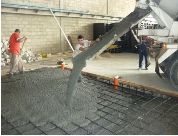
Figura 76. Fundición del concreto
