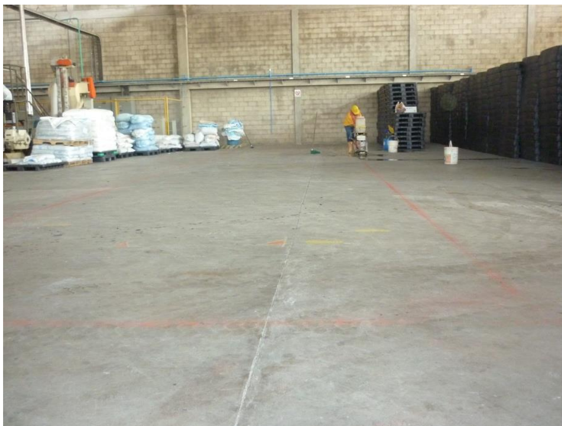
Figura 66. Lugar escogido para la cimentación
