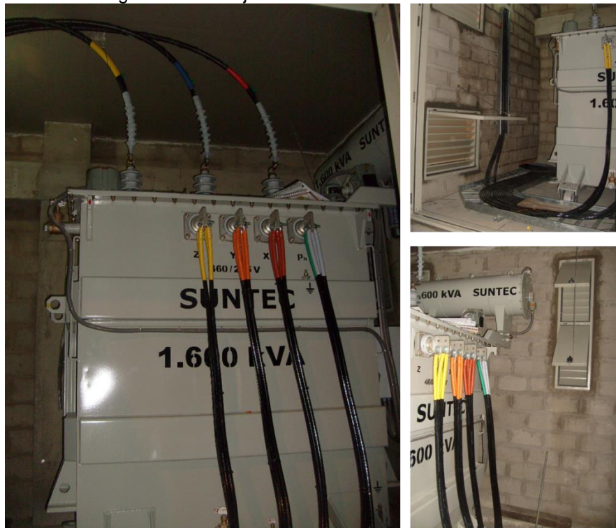
Figura 82. Montaje final de la Subestación eléctrica
