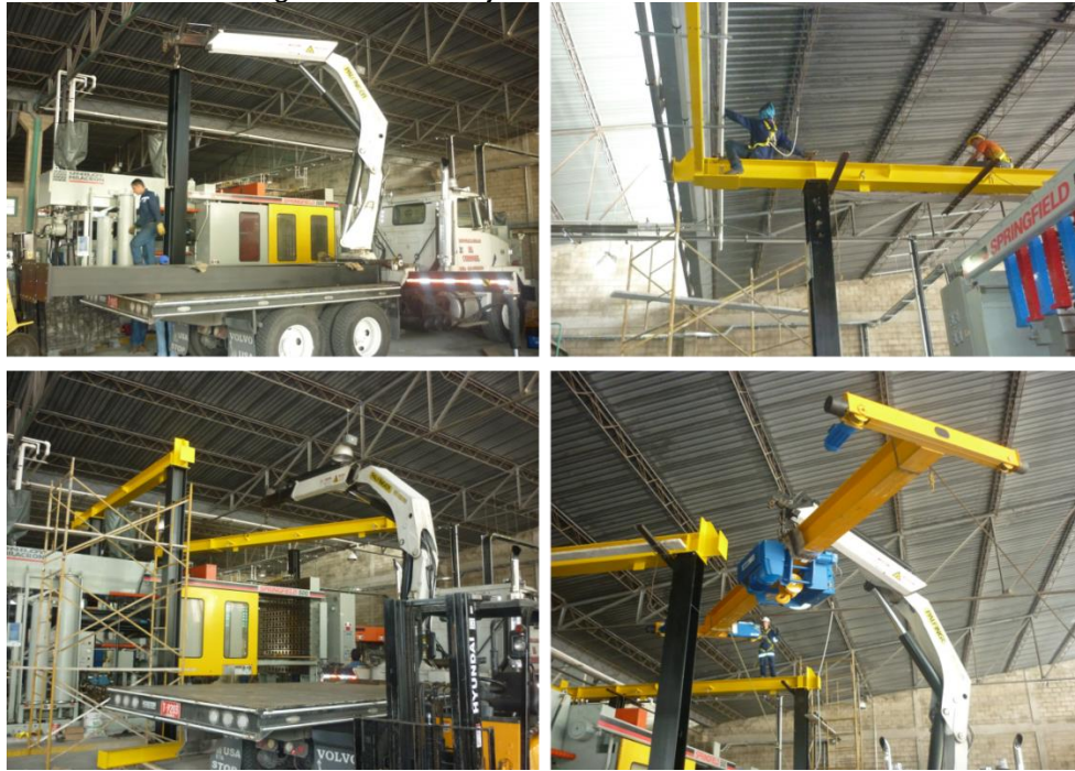
Figura 153. Montaje de la estructura metálica
