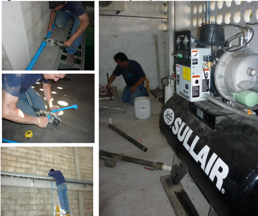
Figura 100. Instalación nueva tubería y compresor de tornillo de 10hp Sullair
