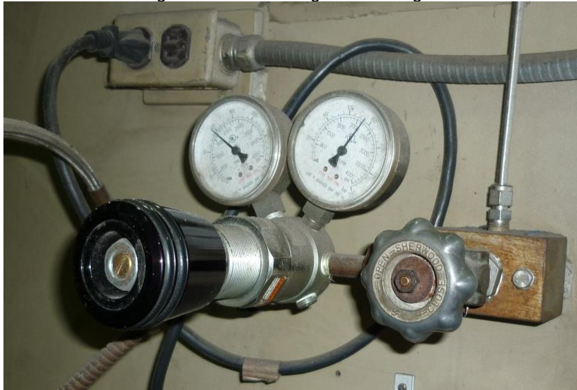
Figura 57. Válvula reguladora de gas
