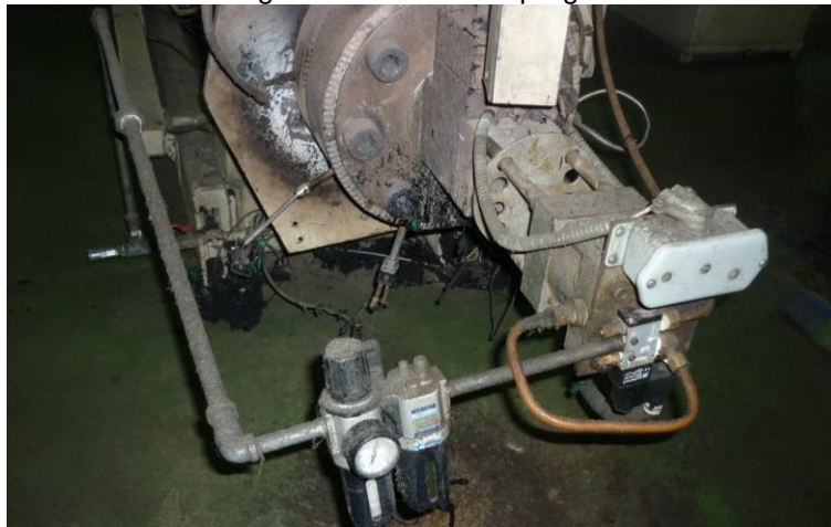
Figura 48. Válvula de purga 26
