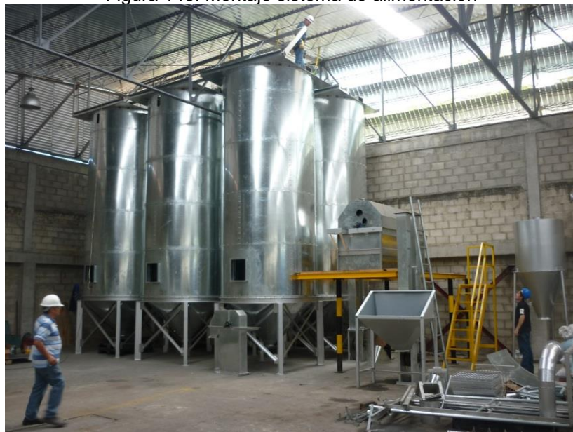
Figura 146. Montaje sistema de alimentación
