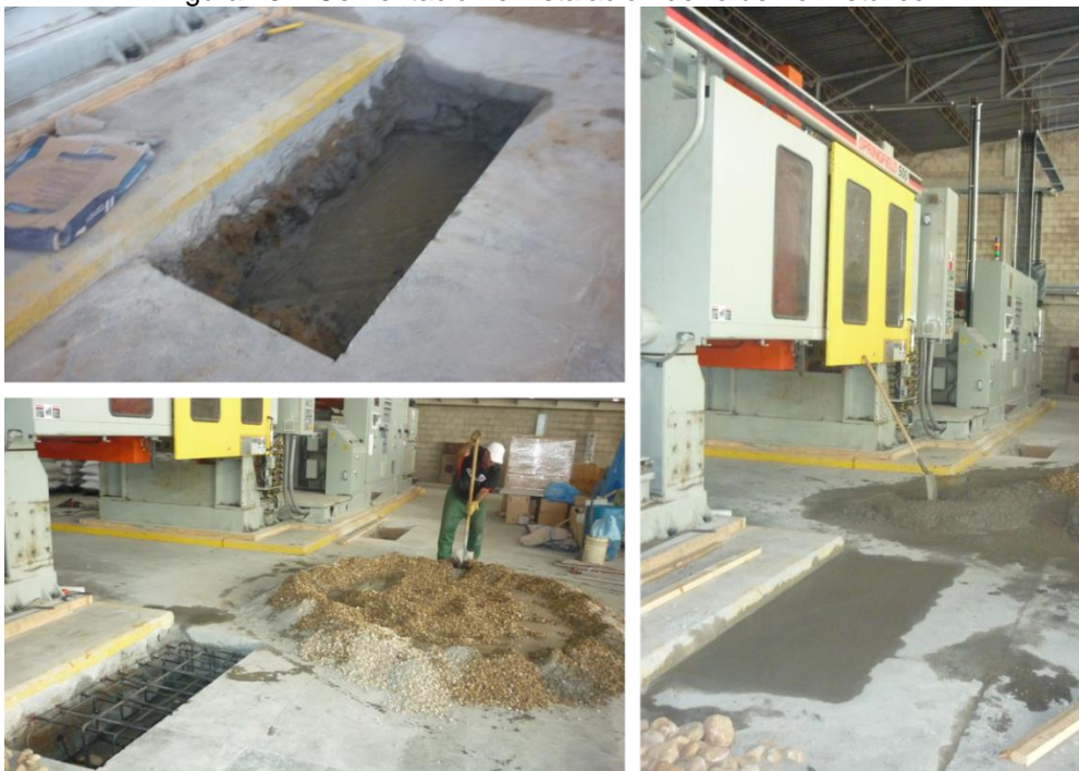
Figura 152. Cementación e instalación de refuerzo metálico
