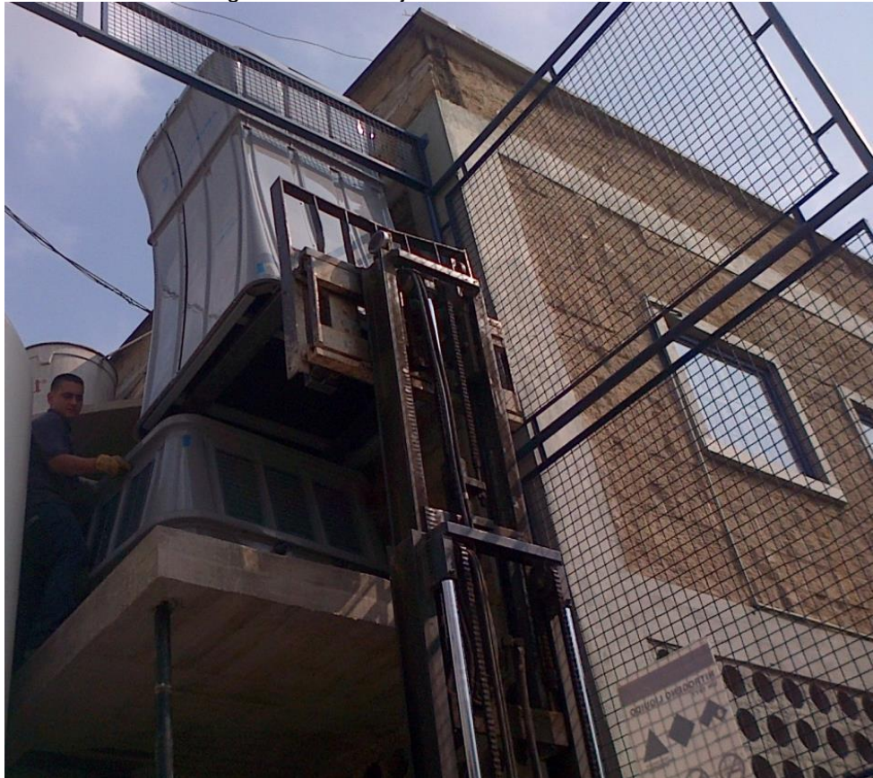
Figura 123. Montaje de la torre de enfriamiento
