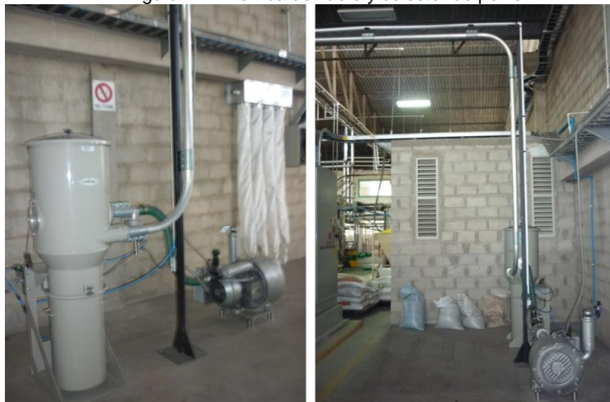
Figura 144. Bomba de vacío y colector de polvo
