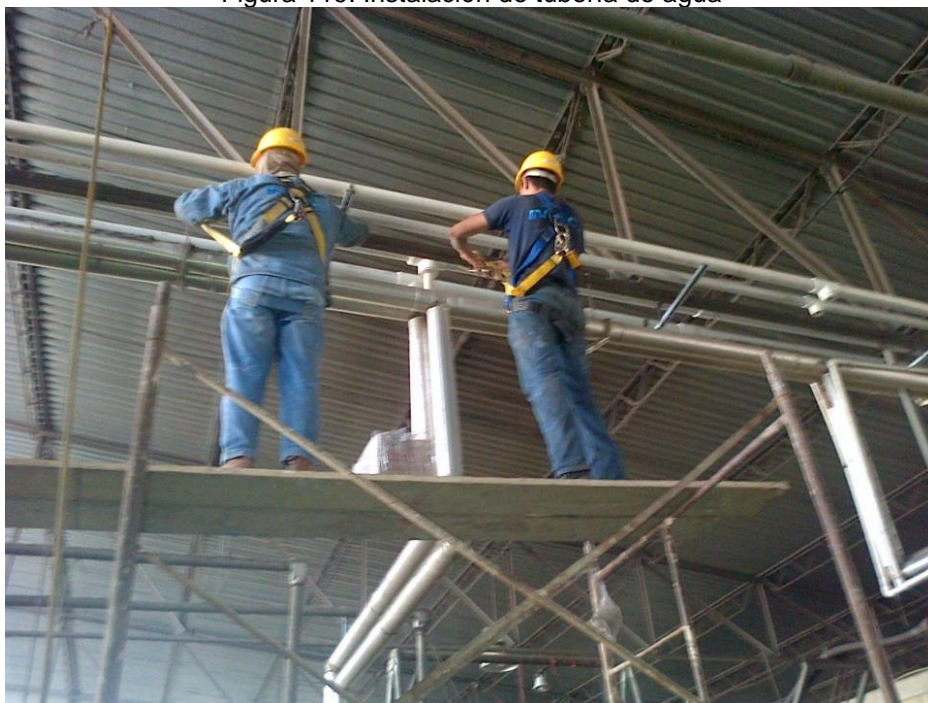
Figura 119. Instalación de tubería de agua
