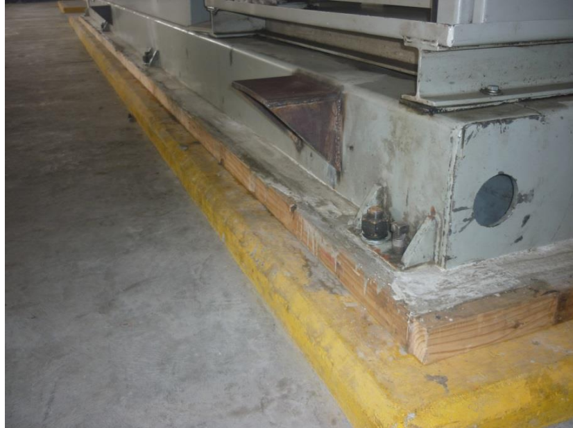
Figura 80. Fundición del grouting
