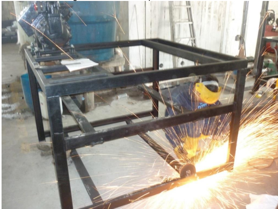
Figura 116. Inicio de operaciones Chiller
