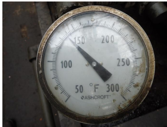
Figura 44. Indicador de Temperatura (TI) a la entrada del enfriador.
