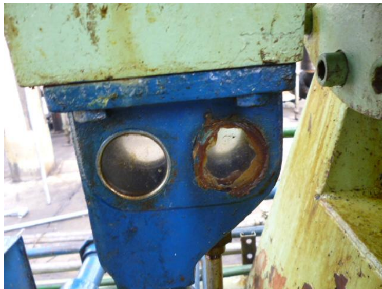
Figura 67. Mirillas en las líneas de retorno de aceite.
