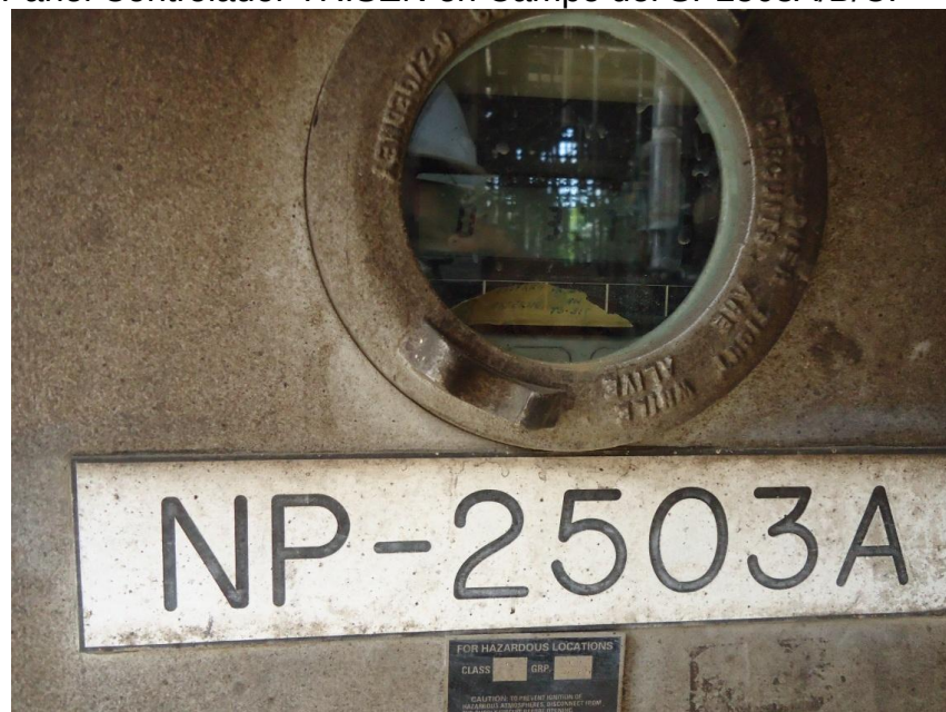
Figura 32. Panel Controlador TRISEN en Campo del SP2503A/B/C.
