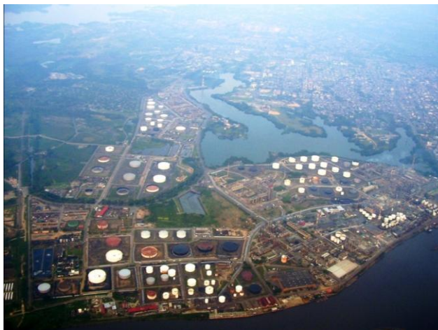
Figura 2. Gerencia Refinería Barrancabermeja.
