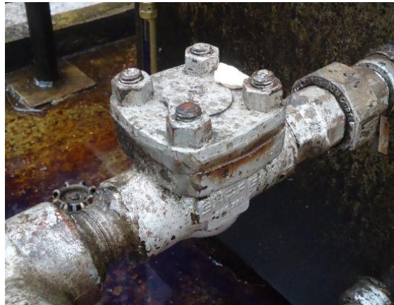
Figura 42. Cheque Antirretorno.
