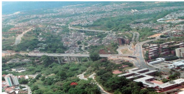
Imagen 14. Viaducto la Flora en la década de los noventa.
