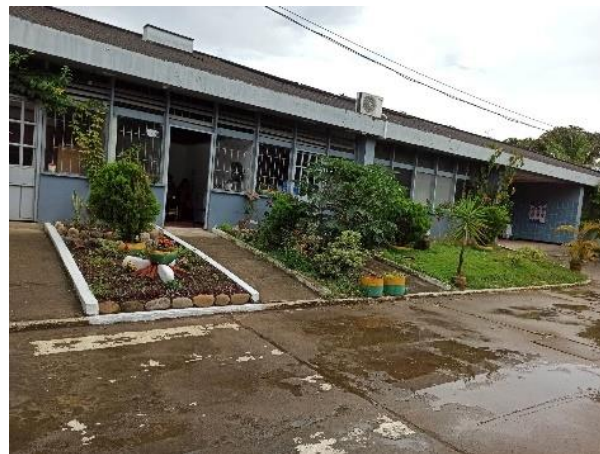
Figura 1. Edificio administrativo, institución educativa INEM.
