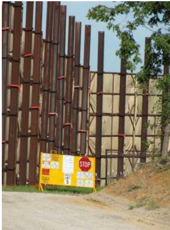
Figura 12. Muro temporal para mitigar el ruido de las operaciones
