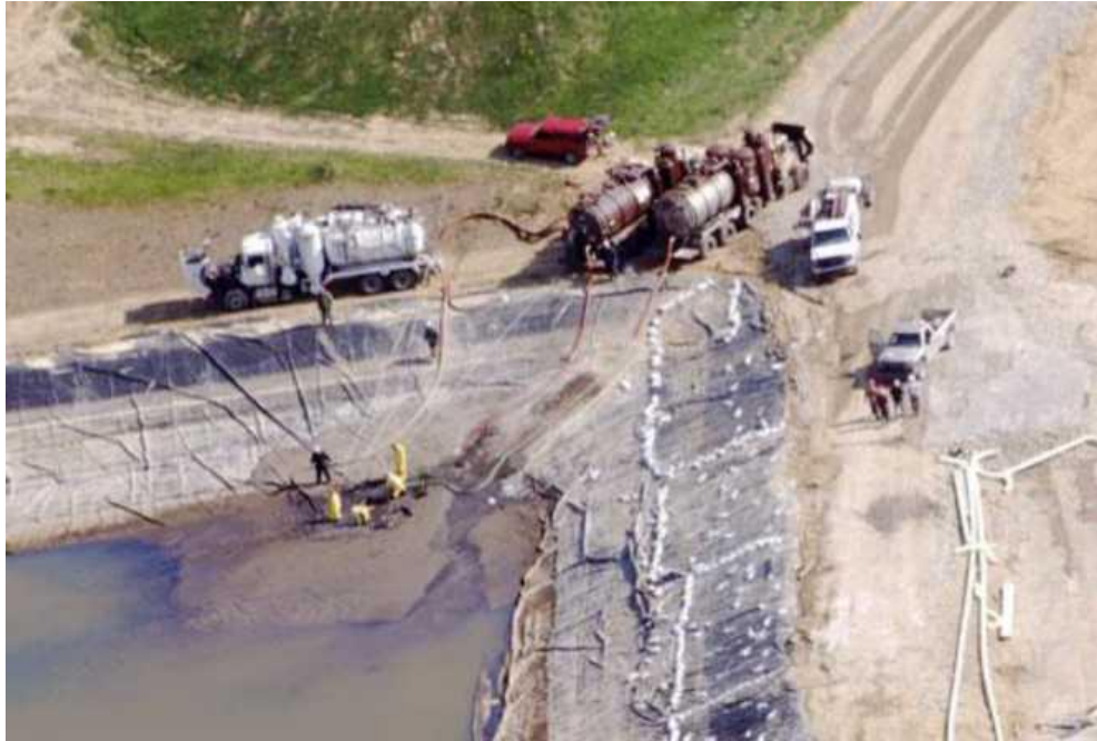
Figura 11. Construcción de una piscina para almacenamiento de aguas de desecho localizada en la zona de la lutita de Marcellus
