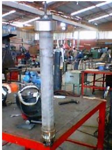
Figura 71.Montaje tubo y acople para soldadura
