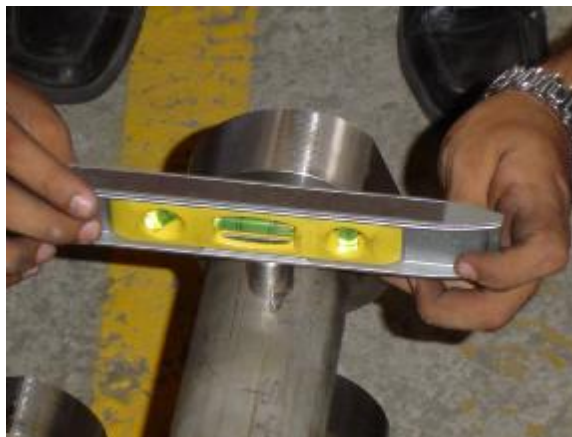
Figura 75. Nivelación de la toma de presión antes de soldarse a los tubos.
