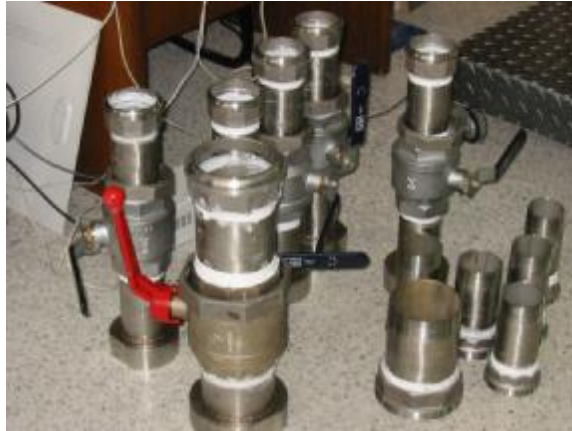
Figura 78. Tubería roscada a los accesorios con teflón y silicona.
