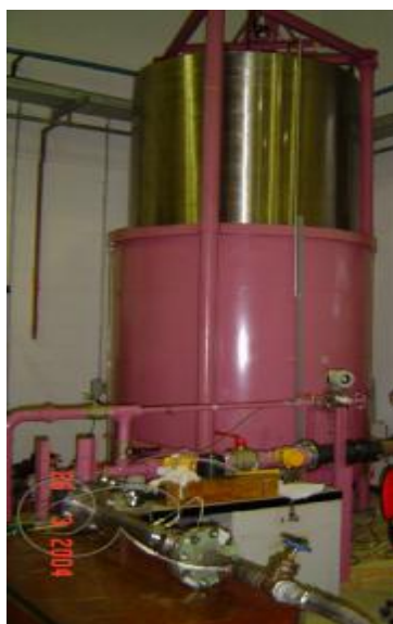
Figura 87. Imagen de instalación para calibración de boquillas con patrón tipo campana gasométrica.
