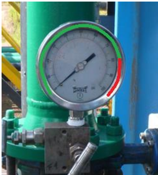
Ilustración 21. Indicadores visuales en manómetro del fluido de proceso
