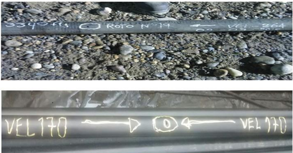
Figura 19. Tubería rota por corrosión en los pozos Vel-264 y Vel-170.
