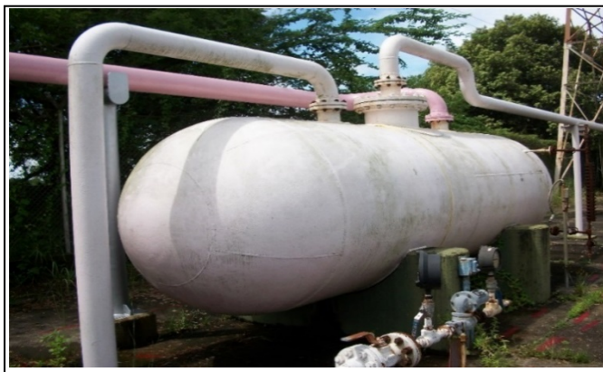
Figura 10 Tambor amortiguador
