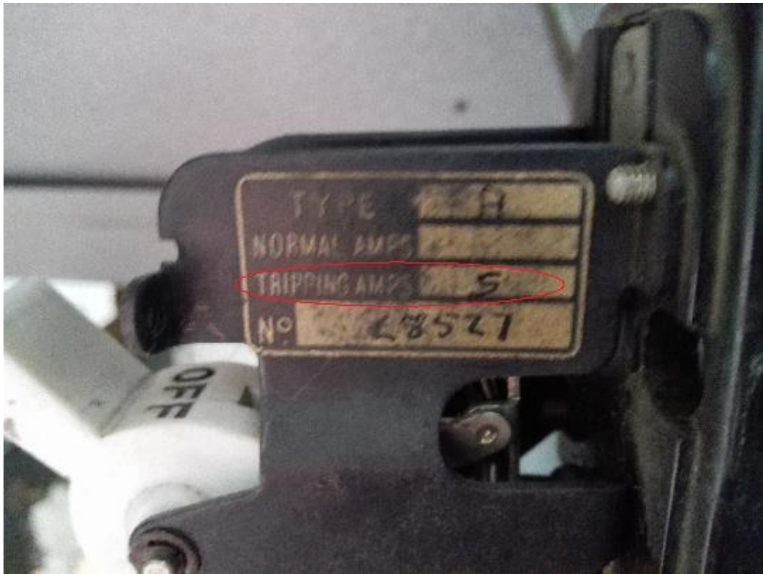
Figura 54. Corriente a la que disparaba el interruptor
