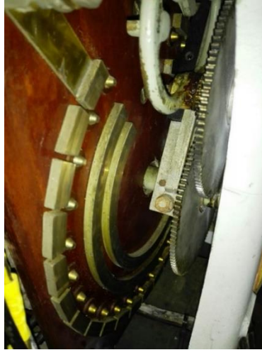
Figura 5. Taps del autotransformador
