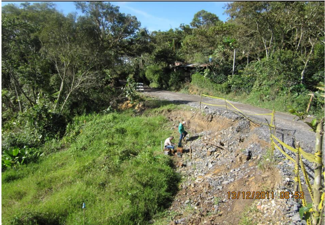
Figura No. 9. Foto del lugar en donde se ejecutó el SEV-2.
