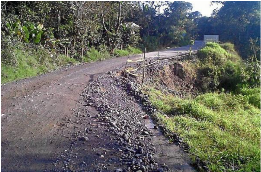
Ilustración 1. Panorámica del talud.
