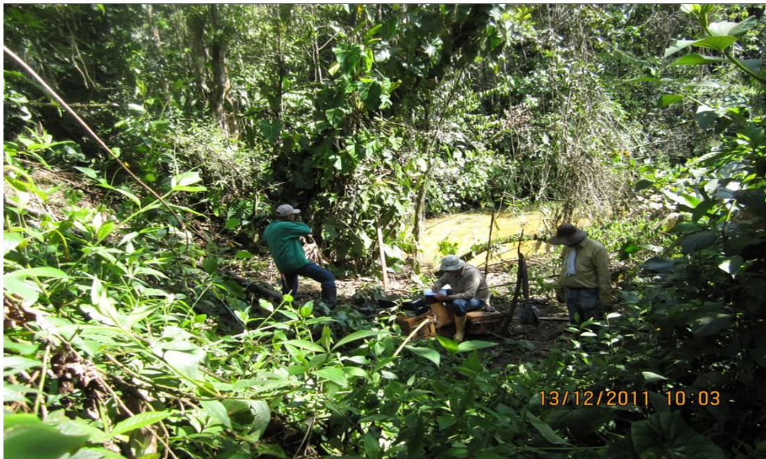
Figura No. 11. Foto del lugar en donde se ejecutó el SEV-3.
