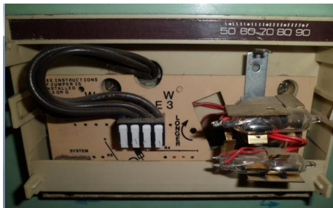
Figura 58. Termostato sin tapa
