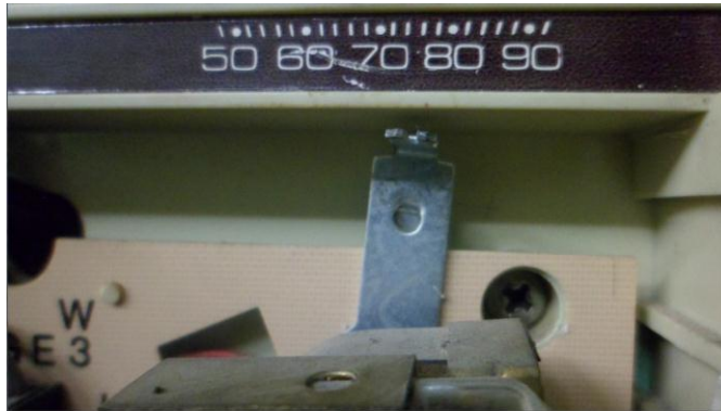
Figura 83. Ajuste del termostato
