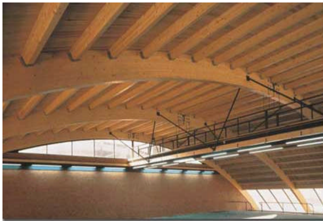
Fotografía 3. Coliseo con cubierta de MLE
