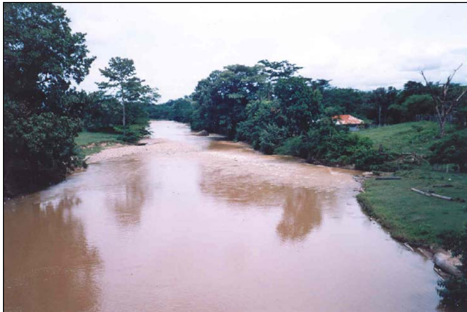
FIGURA 47. Salto de 1.5 m del bloque norte de la Falla San Blas que afecta el Río Inanea, en la zona del puente sobre la vía Simití-San Blas. Nótese el rápido causado por el cruce de la falla sobre el cauce actual.
