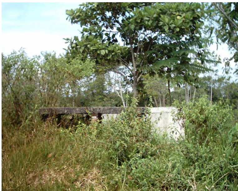
Vista lateral – Entrada planta de tratamiento
