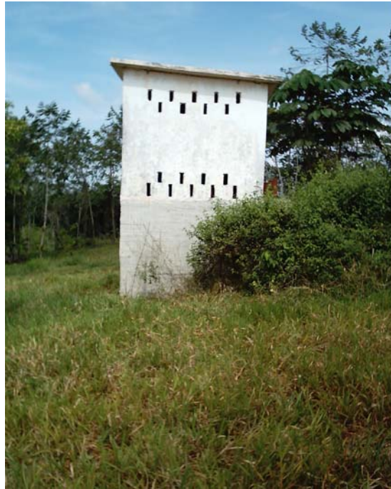
Planta de tratamiento de agua potable
