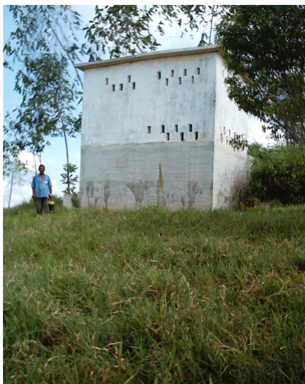
Caseta de cloración y tanque de cloración – planta de tratamiento
