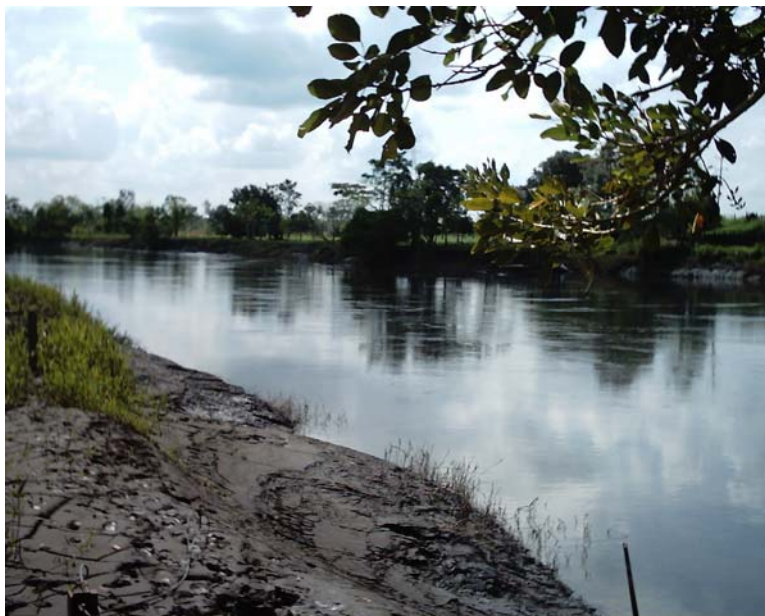
Acumulación de lodos aledaña al punto final de entrega de las aguas residuales
