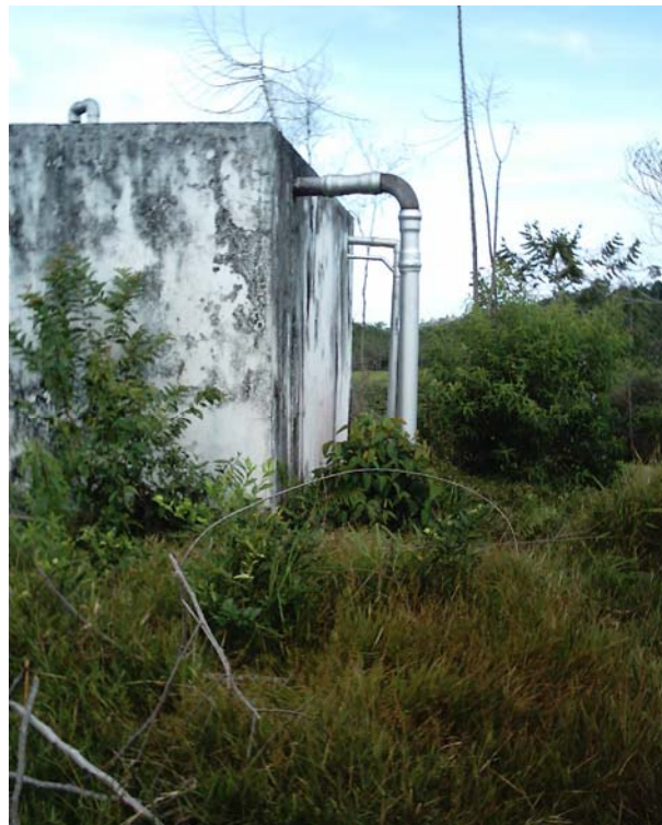
Entrada a la planta de tratamiento
