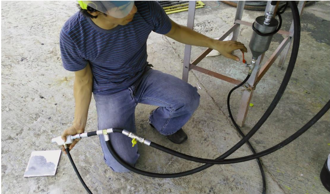
Figura 60. Segunda fase: Regulación de abrasivo
