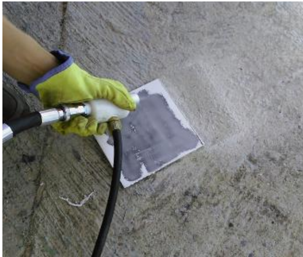
Figura 62. Tercera fase: Preparación superficial por medio de chorro abrasivo
