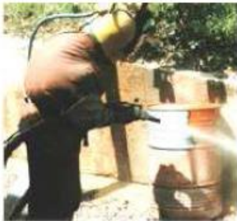
Figura 80. Aplicación de Sand-Blasting y turbina para proyección de Granalla.
