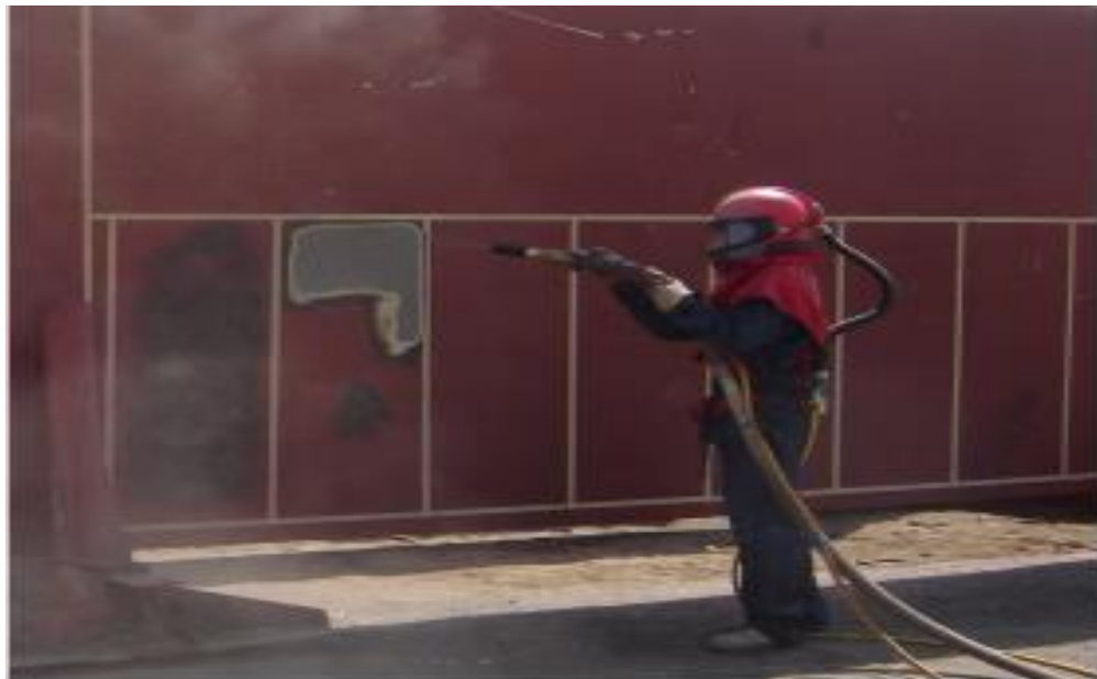
Figura 2. Preparación de superficies por medio de SANDBLASTING
