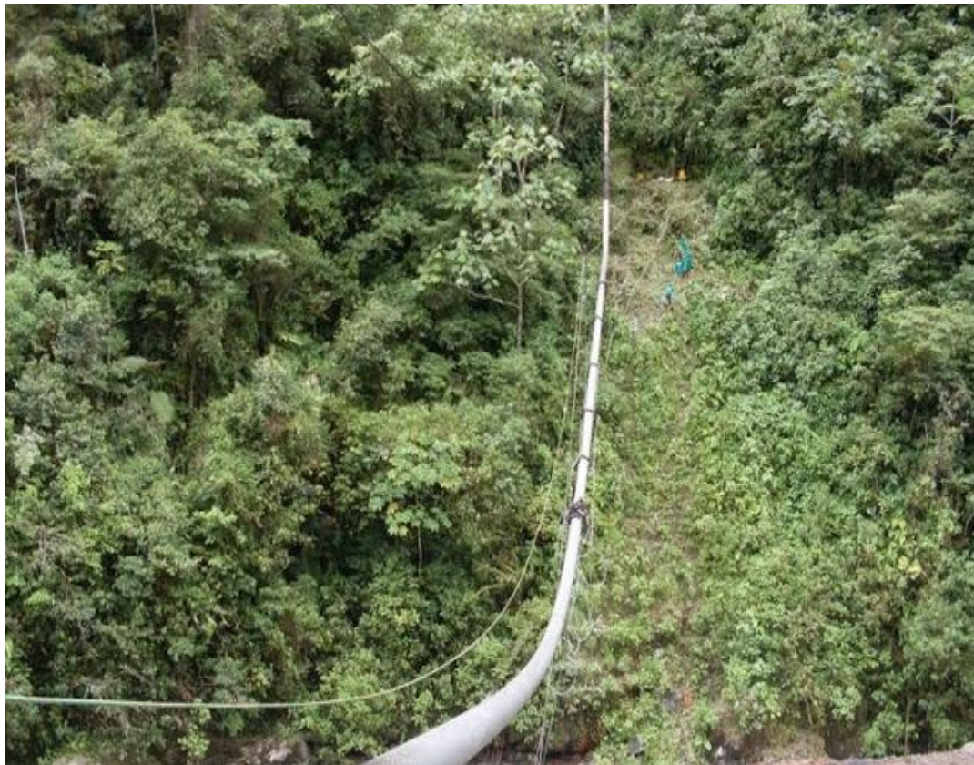
Figura 3. Tubería en zona de difícil acceso
