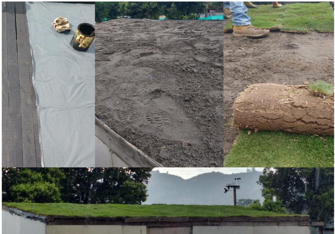
Figura 19. Adecuación de techo verde
