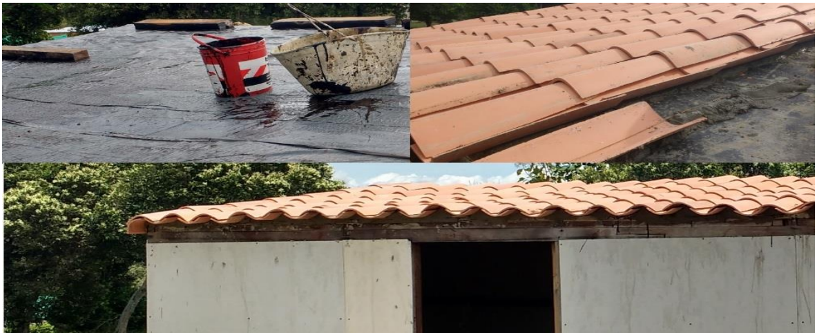
Figura 17. Adecuación de techo de concreto
