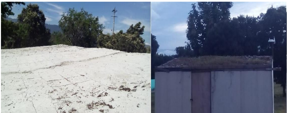
Figura 16. Estado inicial de techos de los recintos
