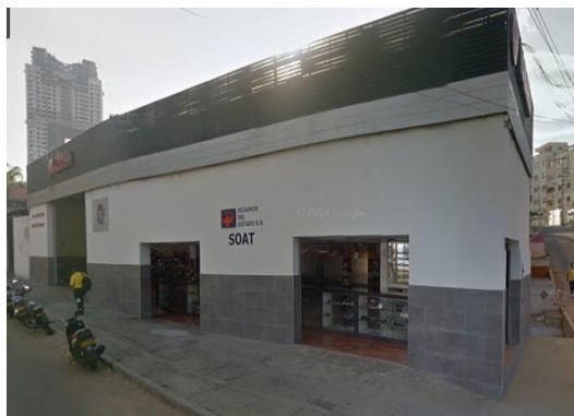
Figura 1. Instalaciones KITMOTOS YAMAHA
