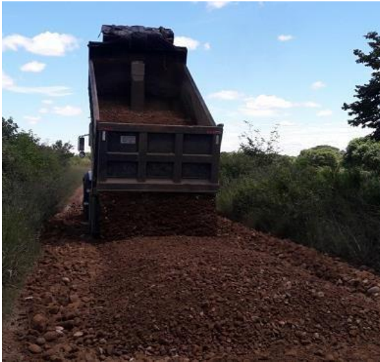
Figura 4.volqueta en proceso de descarga de material pétreo
