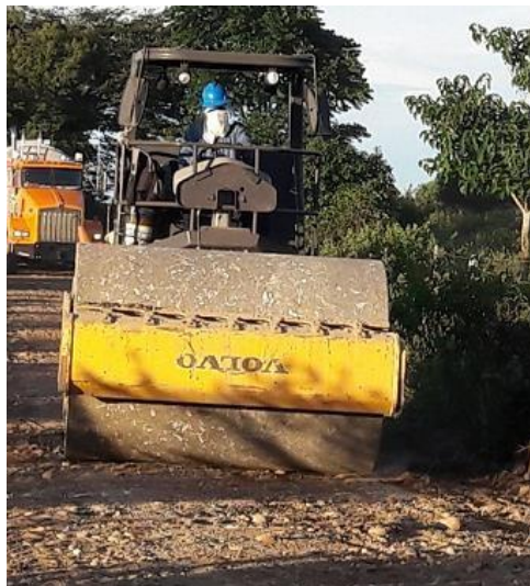
Figura 5. Vibro compactador en proceso de mantenimiento vial
