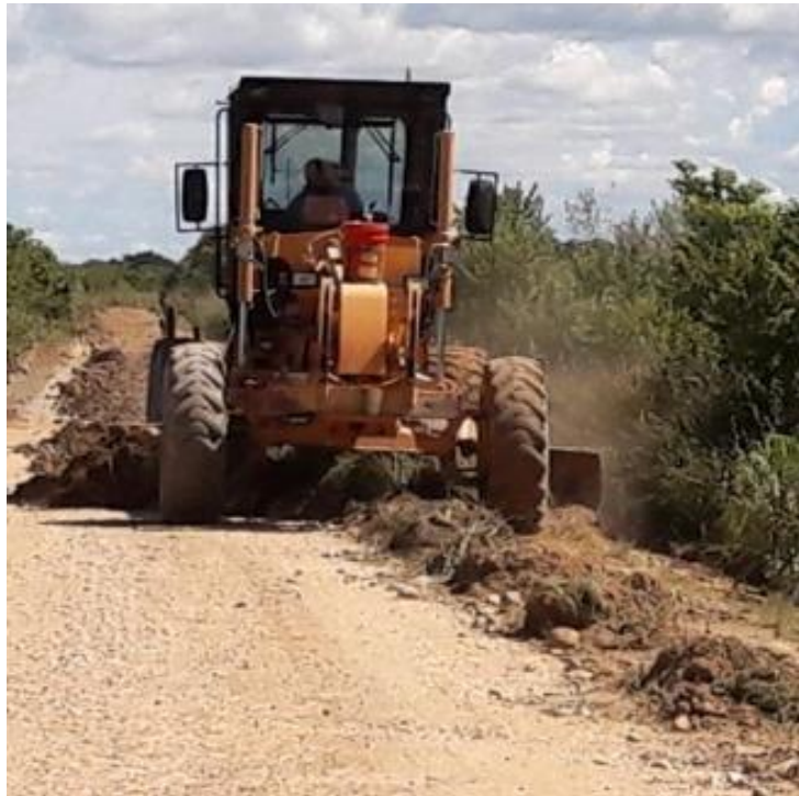
Figura 3. Motoniveladora en mantenimiento de vías
