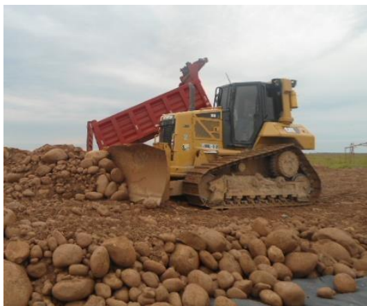
Figura 9. Bulldozer en extensión de material triturado
