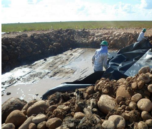
Figura 10. Excavación para piscina de oxidación
