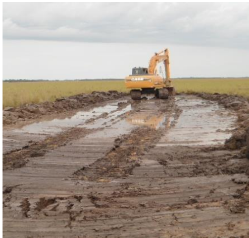
Figura 7. Retroexcavadora sobre orugas en proceso de adecuación de terreno
