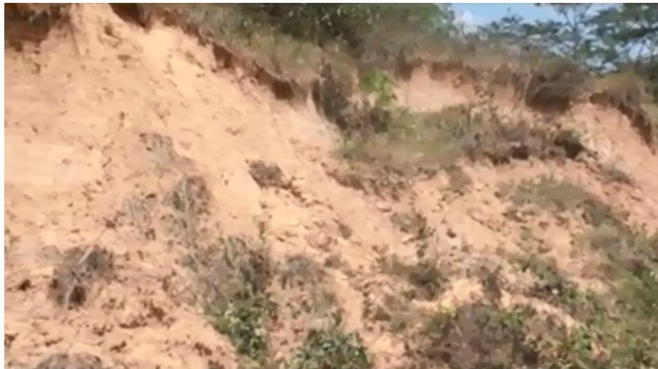
Figura 3-24. Derrumbes por la sísmica.
