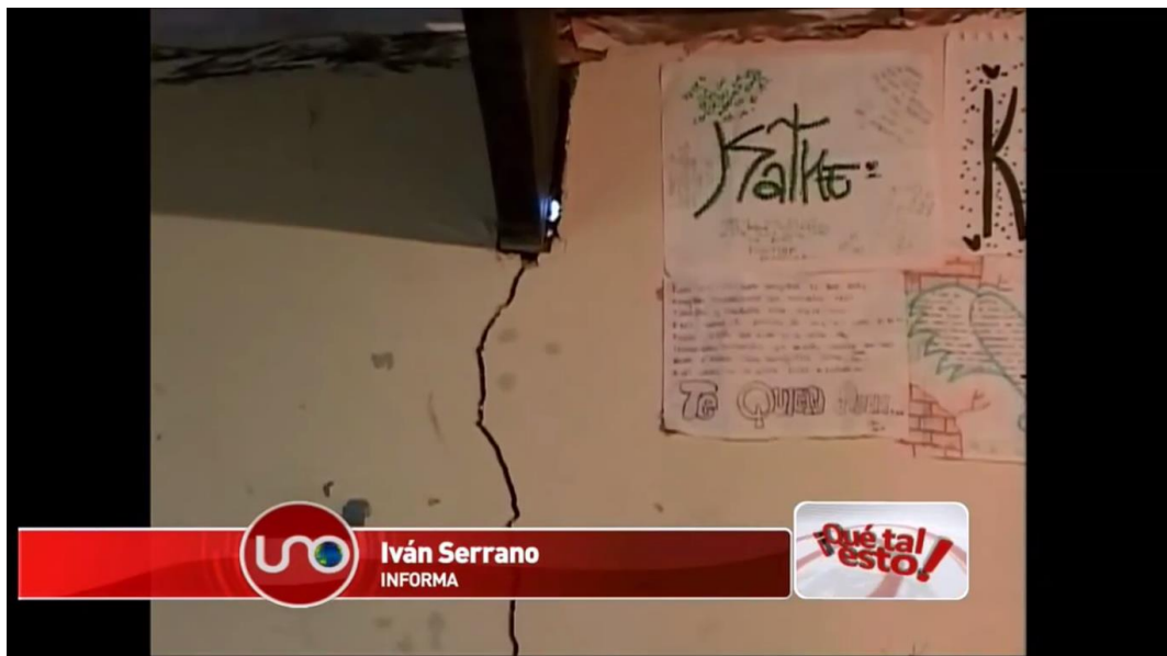
Figura 3-47. Grietas paredes.
