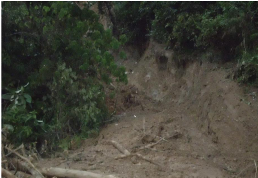
Figura 3-18. Deslizamientos de tierra.
