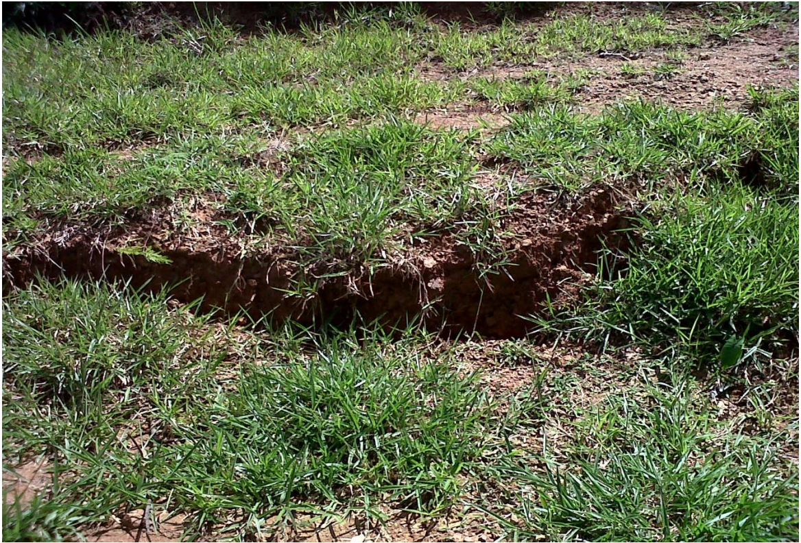
Figura 3-27. Grietas en el terreno.
