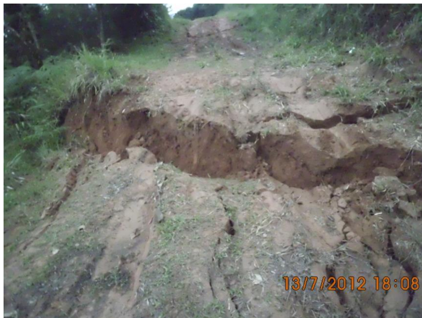
Figura 3-3-33. Agrietamiento del suelo.
