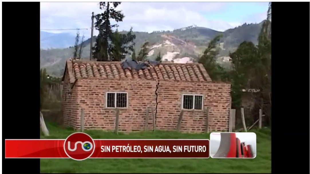
Figura 3-48. Impactos en viviendas.
