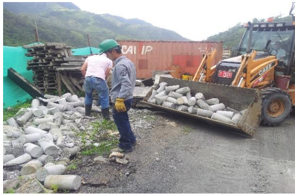
Foto 3. Reciclaje del concreto
