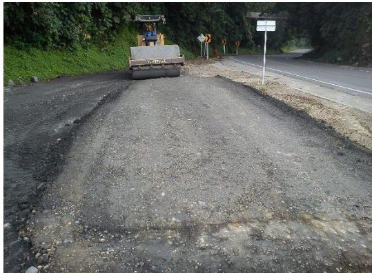
Foto 7. Tramo Experimental con el Agregado Pétreo
