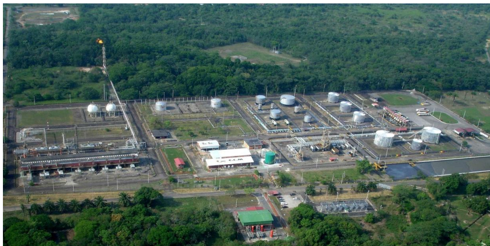
Figura 3. Vista panorámica planta de gas y refinería
