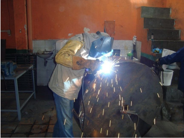
Figura . Soldadura del tanque
