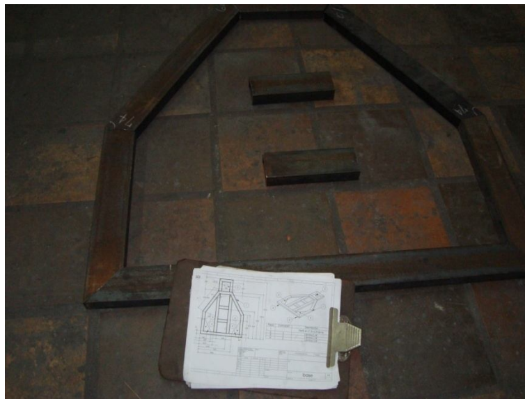
Figura . Armado preliminar de la estructura
