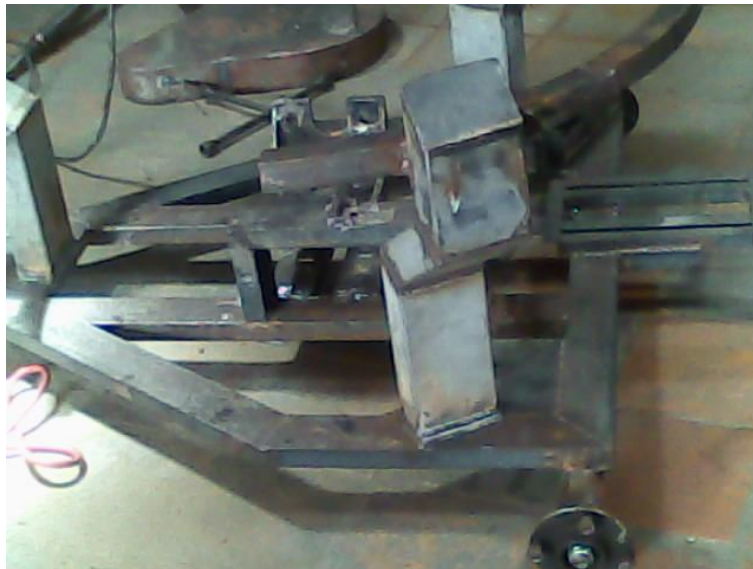
Figura . Estructura terminada
