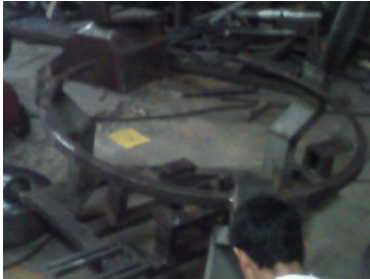
Figura . Construcción del soporte para el tanque en la estructura
