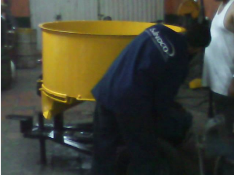
Figura . Montaje del tanque de mezclado
