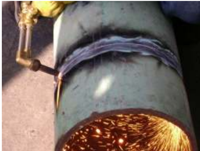
Figura 38. Corte de tubos
