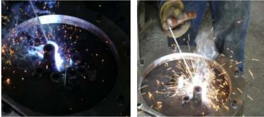
Figura 42. Soldadura del haz de tubo
