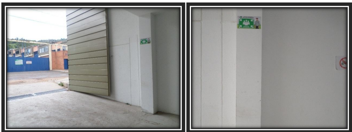
Figura 19. Señalización de zona de parqueadero
