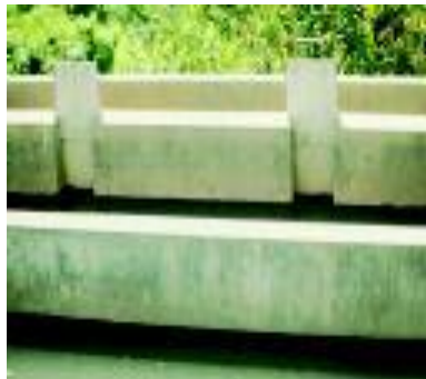
Figura 14: Ingreso con dos compuertas. (Fuente CEPIS/OPS)
