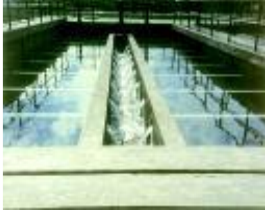
Figura 20: Sistema de recolección en funcionamiento. (Fuente CEPIS/OPS)
