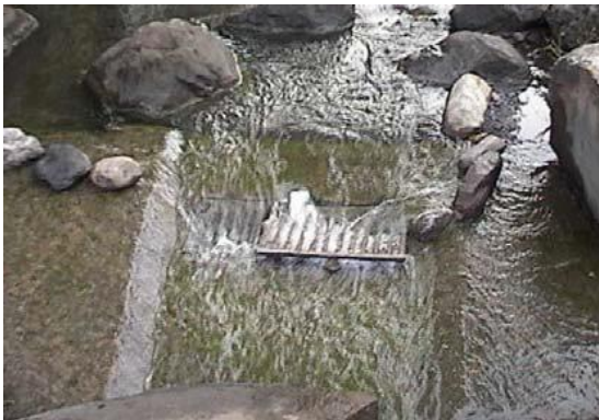
Figura 3: Bocatoma de fondo
