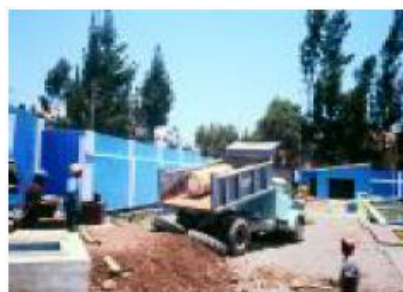
Figura 32: Operación de descarga de alto riesgo. (Fuente CEPIS/OPS).
