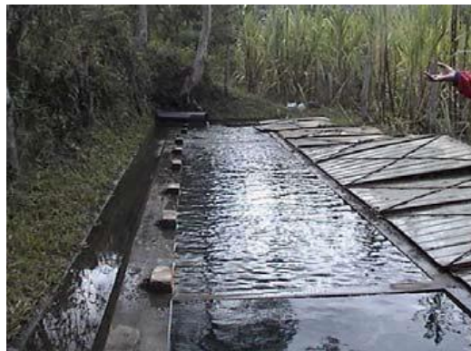
Figura 5: Panorámica sedimentador
