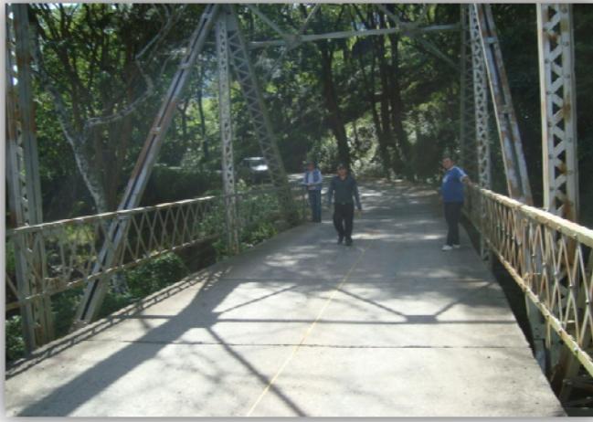
Figura 9. Levantamiento de puentes
