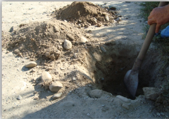
Figura 8. Apiques para determinación de espesores de las capas y características Extracción de muestras de subrasante.
