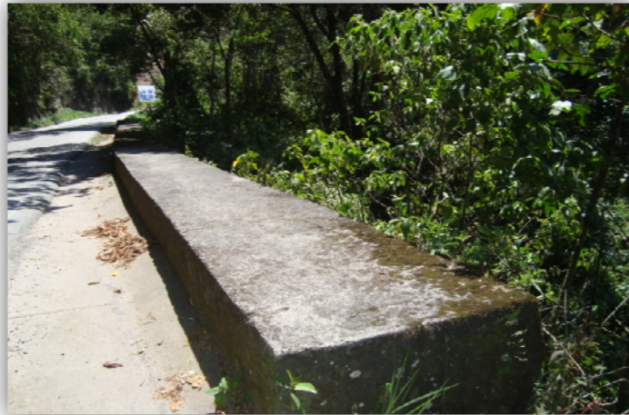
Figura 13. Muro de contención
