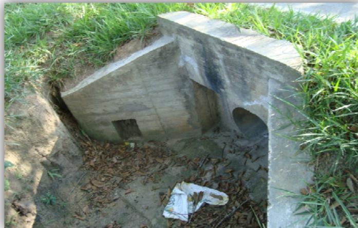
Figura 46. Entrega del filtro a la alcantarilla
