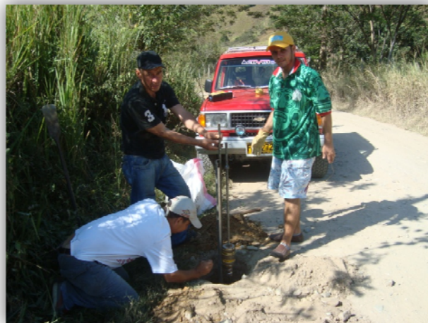
Figura 7. Ensayo de penetrómetro de cono.
