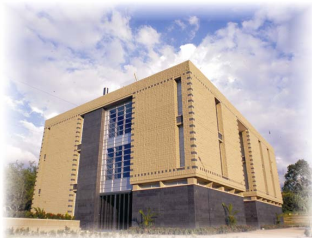
Foto No. 1 Fachada
