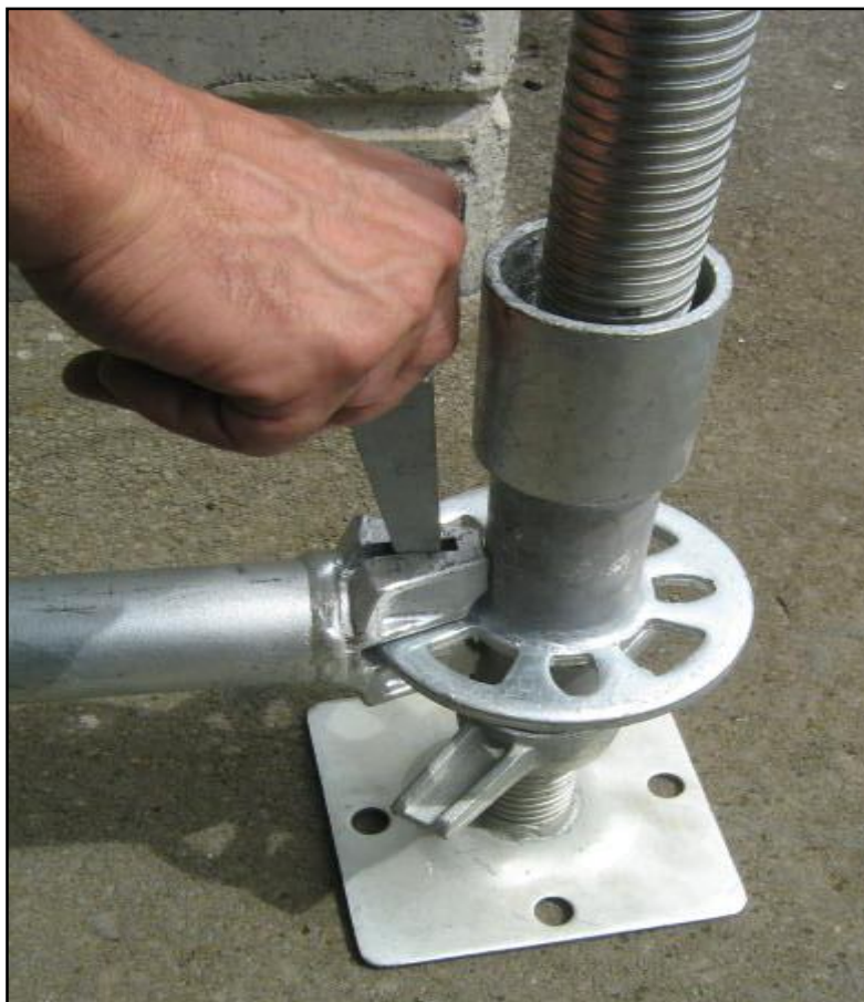
Foto 8 Ensamble de la cuña en la roseta.
