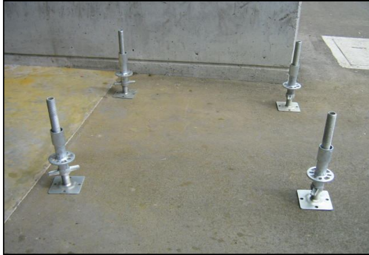
Foto 6 Collarín sobre tornillos niveladores inferiores.
