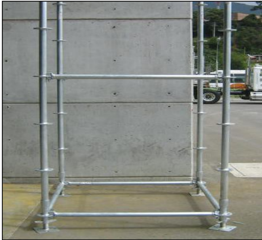
Foto 13 Instalación horizontal multidireccional.
