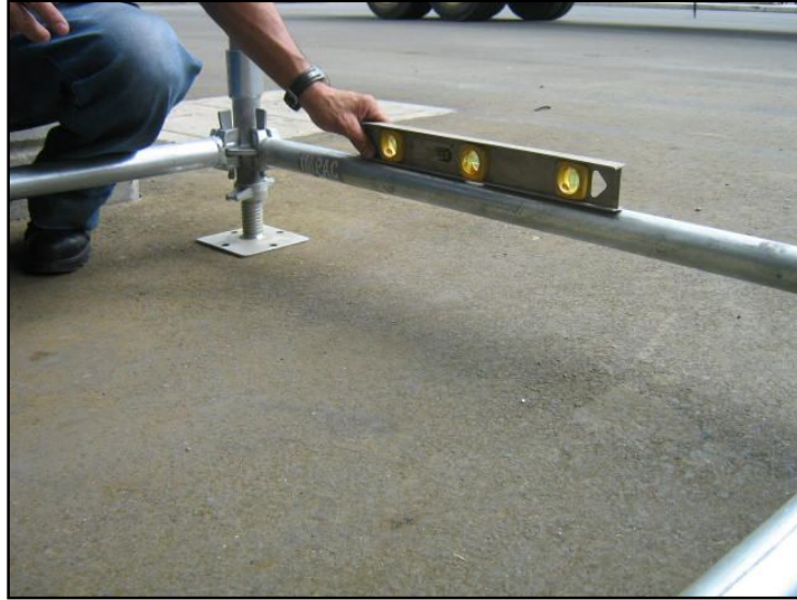
Foto 9 Nivelación de horizontal multidireccional.
