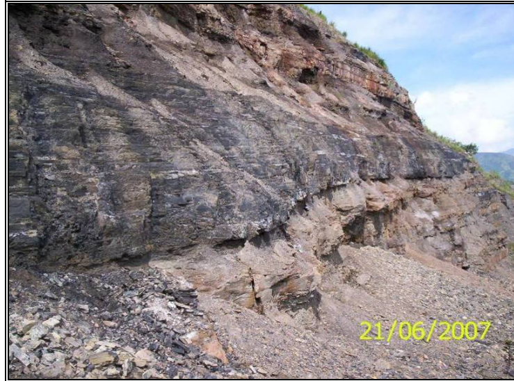
Figura 49. Manto 05 (Tajo CMU): Hacia el techo del manto éste tiende a hacerse mas laminado.
