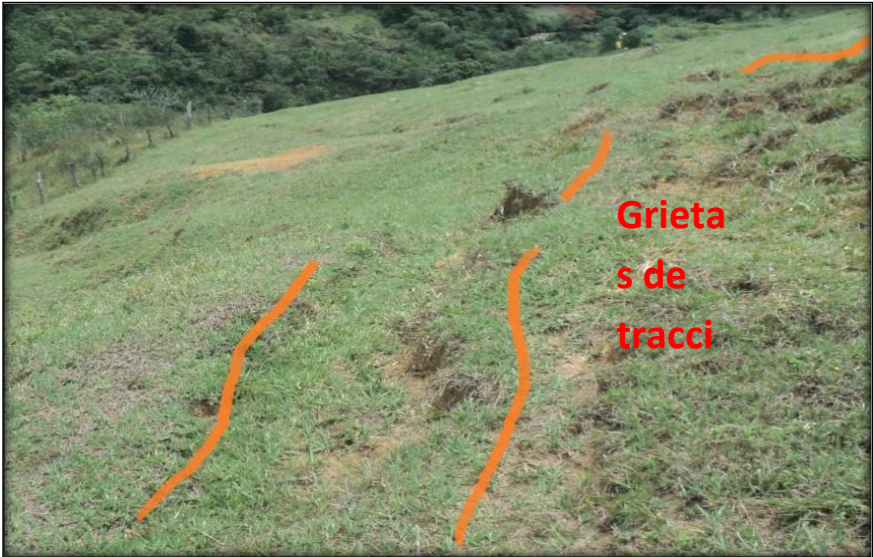
Ilustración 34. Sobre el talud superior de la vía
