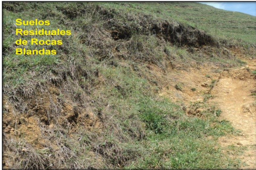
Fotografía 7. Suelos residuales de rocas blandas, talud superior de la vía
