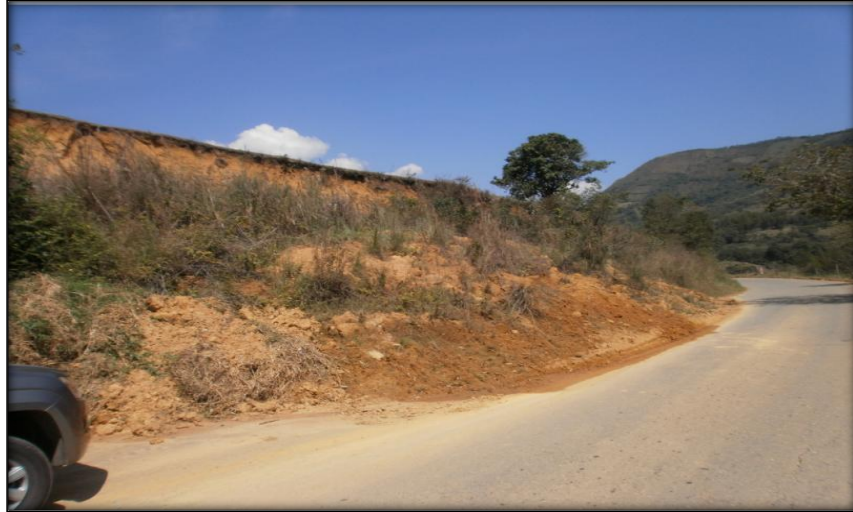
Fotografía 13. Descripción del talud ubicado
