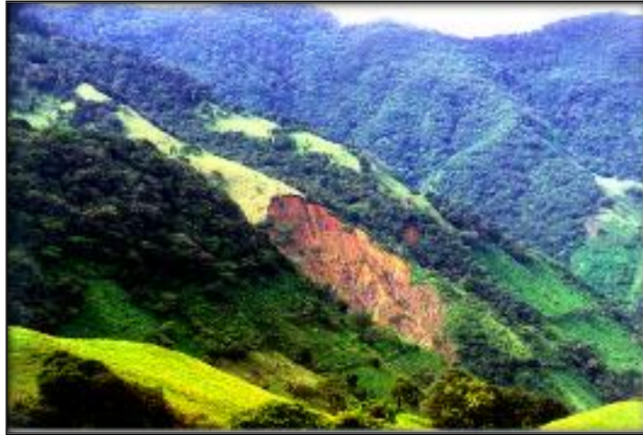
Fotografía 1. Deslizamiento Quebradas, Santa Ana, Costa Rica, se aprecia la superficie original del terreno
