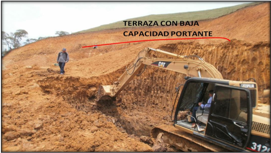
Fotografía 15. Panorámica de la terraza
