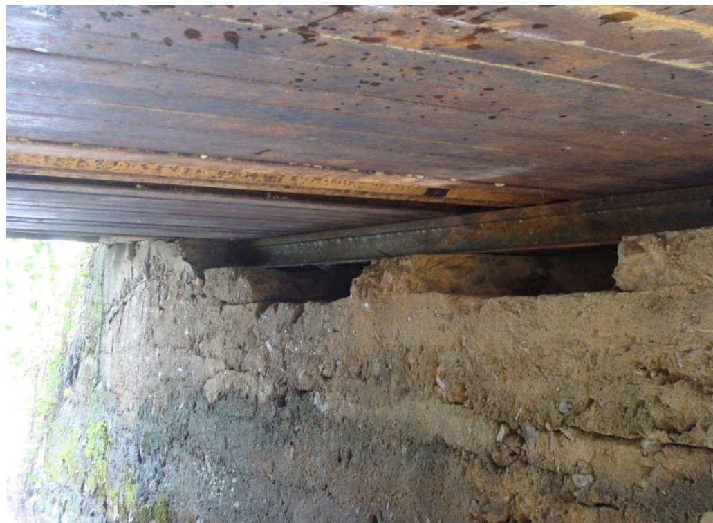
Figura 17. Parte inferior del Box 9.
