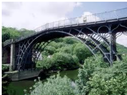
Figura 1. Puente de Coalbrookdale sobre el río Severn
