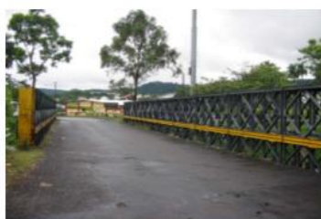
c) Calzada de pavimento asfáltico.
