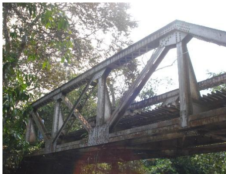
Figura 3. Parte lateral del puente Chocóa, Sabana de Torres, Santander (COLOMBIA).
