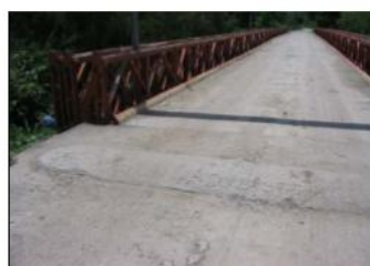
d) Calzada de concreto hidráulico.
