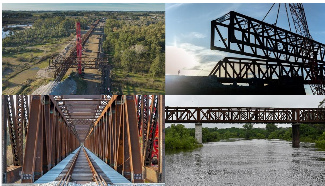
Fig. 26 – En la secuencia de fotos se observa el montaje final de las antiguas celosías envolviendo las nuevas (arriba), y la configuración final en operación (abajo).
