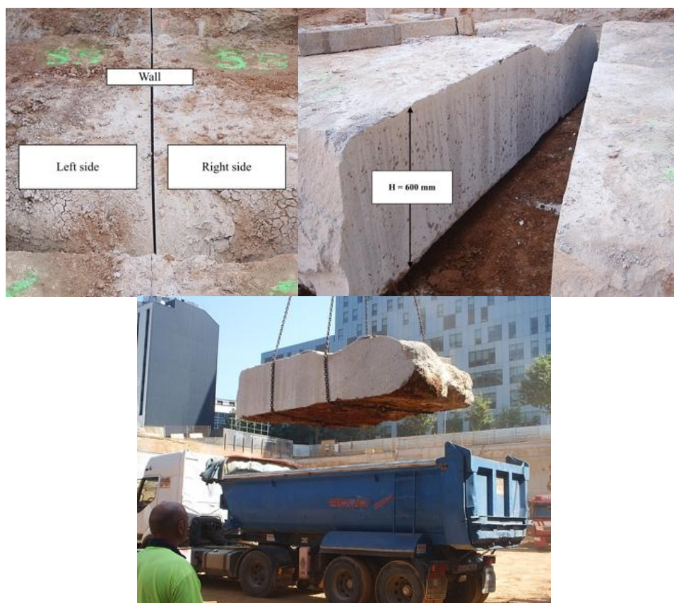
Fig. 2 – Proceso de corte y transporte de bloques de hormigón [2] a) y b) Corte aplicado; c) Manipulación y transporte
