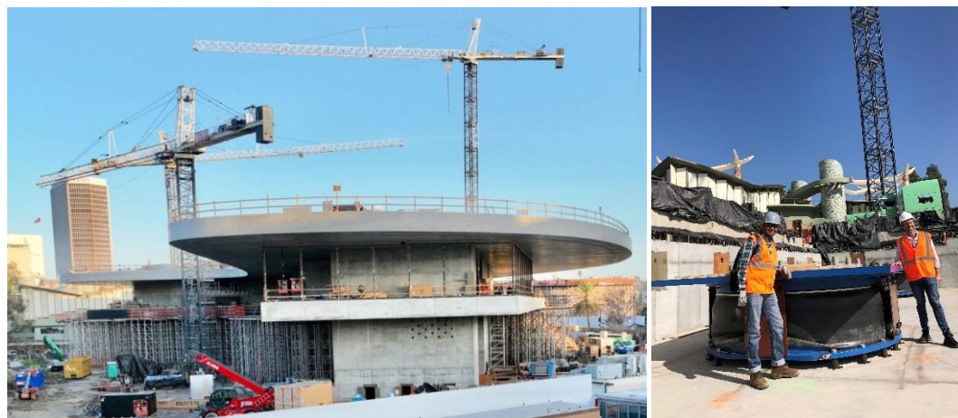
Fig. 6 – Construcción de la superestructura aislada (izquierda) e instalación de uno de los apoyos pendulares (derecha)
