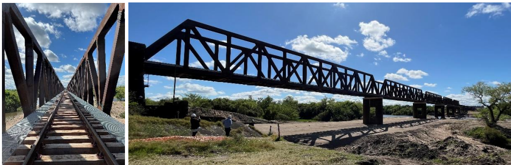
Fig. 25 – Ejemplo de celosías invertidas no arriostradas, tipo pony.
