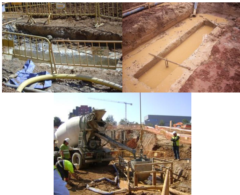
Fig. 2 – Proceso de ejecución de muros de cimentación [2]
