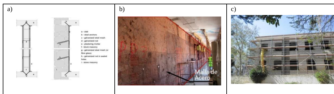
Figura 8. a) Reforzamiento de la Escuela Tomás Cabreira: a) detalles típicos de una solución de mortero de enlucido reforzado con malla de acero, b) aplicación de malla de acero in situ (hojas interiores), y c) aplicación de malla de fibra de vidrio in situ (hojas exteriores) [42].
