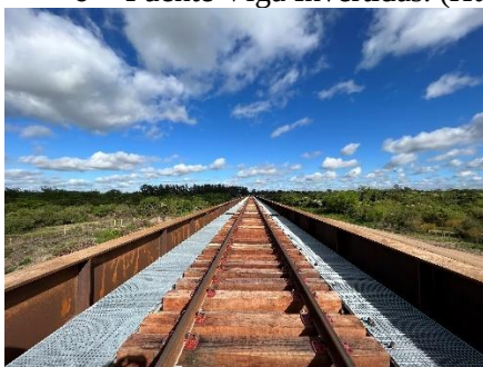
Fig. 24 – Ejemplo de tableros de vigas invertidas adoptados
