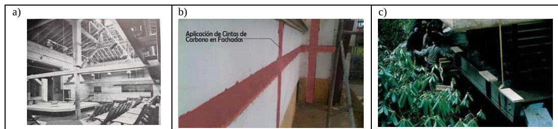
Figura 5. Nuevos usos a partir de refuerzo de estructuras: a) estructura de la cubierta en cerchas de madera, escenario y silletería [32], b) reforzamiento de la fachada con cintas de carbono [33], y c) instalación provisional de las terrazas en la Casa de la Cascada [34].
