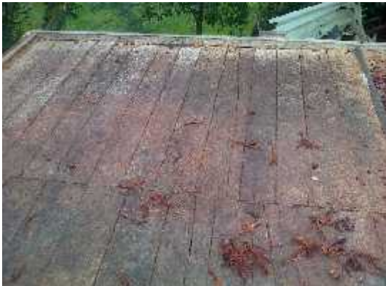
Ilustración 4 Paseras de Madera Deteriorada
