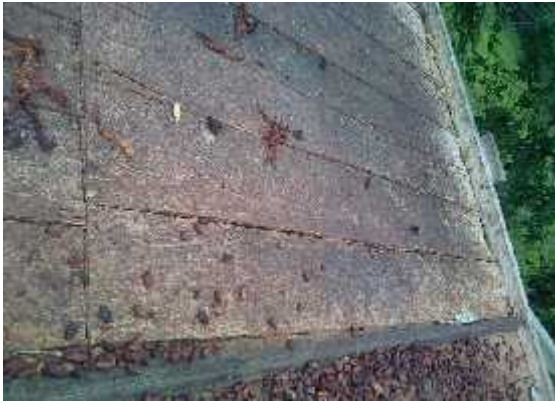
Ilustración 4 Paseras de Madera Deteriorada
