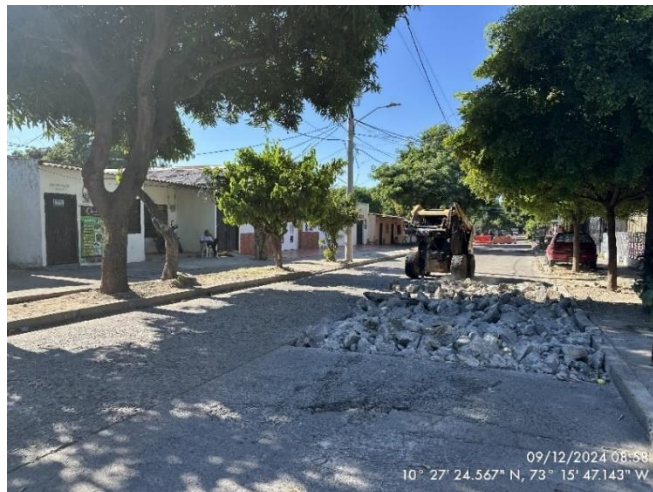
Demolición de losas en concreto hidráulico con minicargador
