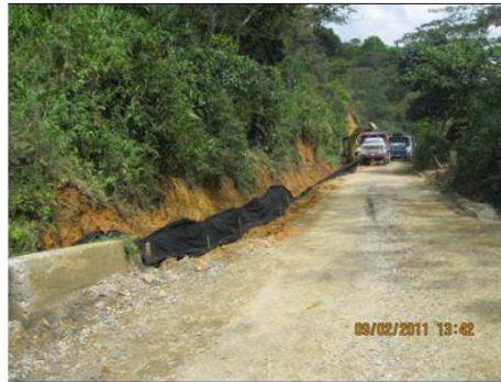
Foto No3 Construcción de filtros en el k16+220 MD
