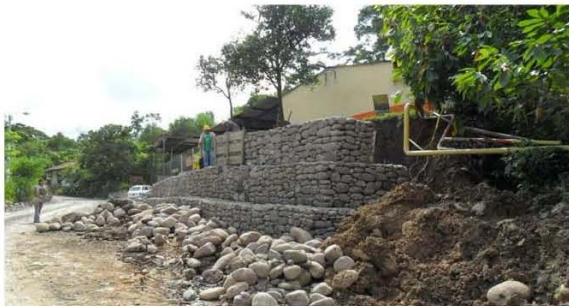
Foto No 4. TERMINACION MURO EN GAVIONES K41+690
