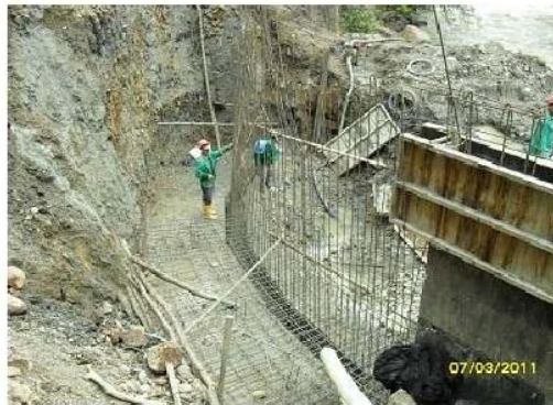
Foto No 8. PR 24+210 Formaleta para muro.
