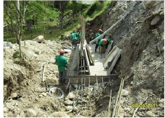
Foto No 4. PR 23+000 Formaleta para muro.
