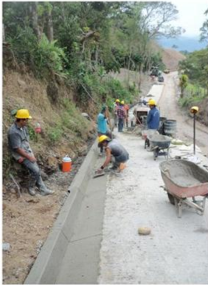
KM 6+702 - KM 6+550 RELLENO PARA ESTRUCTURAS EN MATERIAL COMUN (CUNETAS), CUNETAS EN CONCRETO DE 3000psi FUNDIDA EN EL LUGAR
