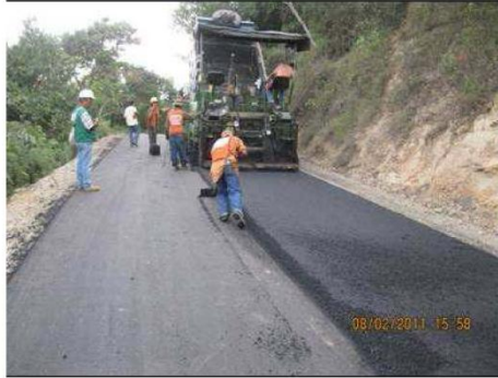
Foto No 1. Pavimentación en el k22+560 carril derecho.
