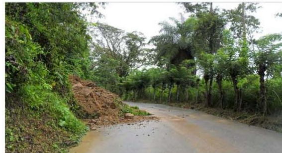
Foto No 8. REMOCION DE DERRUMBES.
