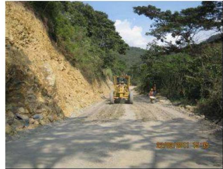
Foto No 10. Conformación de subrasante en el k16+000
