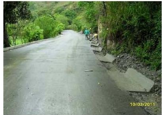
Foto No 2. PR 19+980 Fundida cunetas.
