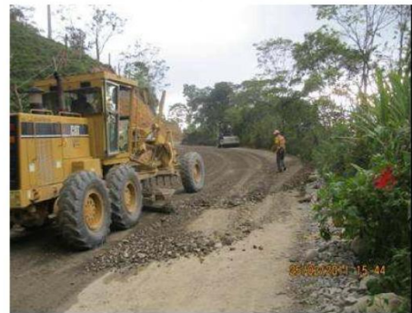
Foto No 12. Conformación sub base en el k15+400
