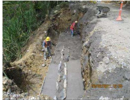
Foto No 4. Construcción muro en el k15+310 MI
