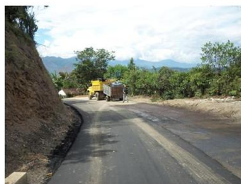
KM 6 +495 - KM6+016 CD; KM 6+495 - KM 6+199 CI Barrido, soplado y riego de imprimación con emulsión asfáltica
