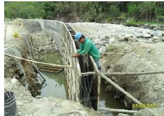
Foto No 6. PR 22+880 Formaleta cuerpo muro.
