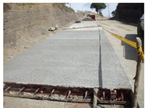
KM 6+820 - KM 6+804 Construcción Concreto Rígido MR 42 placa
