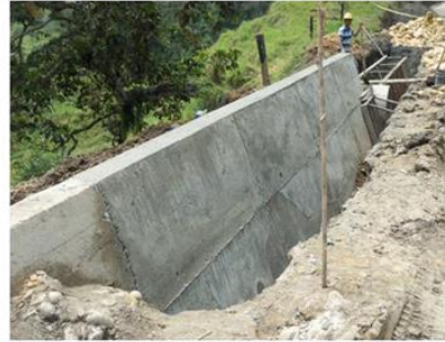
KM 4+990; KM 5+010 CONCRETO CLASE G (60% clase f y 40% piedra, Muros)
