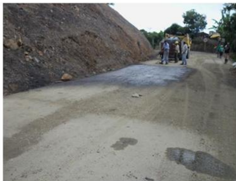
KM 6 +495 - KM6+016 CD; KM 6+495 - KM 6+199 CI Barrido, soplado y riego de imprimación con emulsión asfáltica
