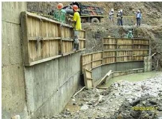
Foto No 3. PR 24+210 Formaleta para muro.
