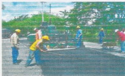
FOTO No. 1. Construccion MDC-2 K2+500
