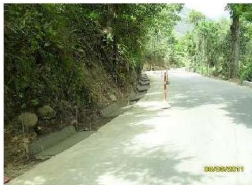
Foto No 7. PR 20+020 Fundida de cunetas.
