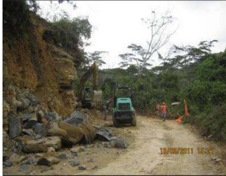
Foto No 7. Corte talud en el k15+980 MI
