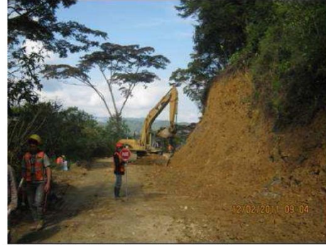
Foto No 2 Corte talud en el k16+110 MD.
