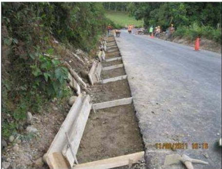
Foto No 5. Construcción cunetas en el k11+530
