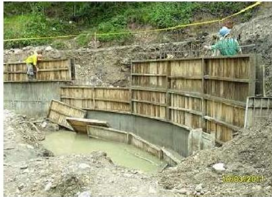
Foto No 5. PR 24+210 Formaleta para muro.
