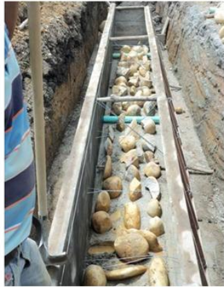
KM 4+990; KM 5+010 CONCRETO CLASE G (60% clase f y 40% piedra, Muros)
