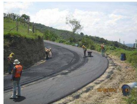
Foto No 6. Pavimentación en el k23+480
