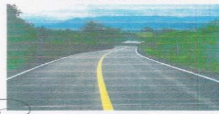
FOTO No. 6. Demarcacion terminada K3+000
