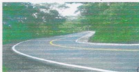
FOTO No. 5. Demarcacion terminada K0+700
