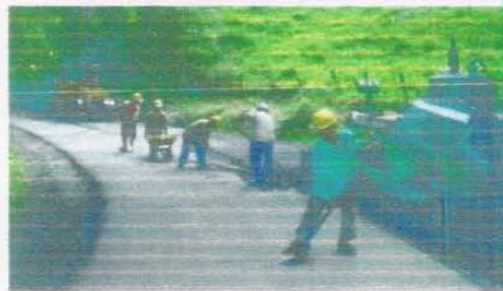
FOTO No. 2. Pavimentación con MDC-2 K3+050
