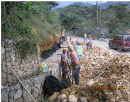
Foto No 11. Muro en gaviones en el k16+300 MD
