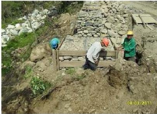
Foto No 1. PR 23+490 L.I. Muro en gaviones.
