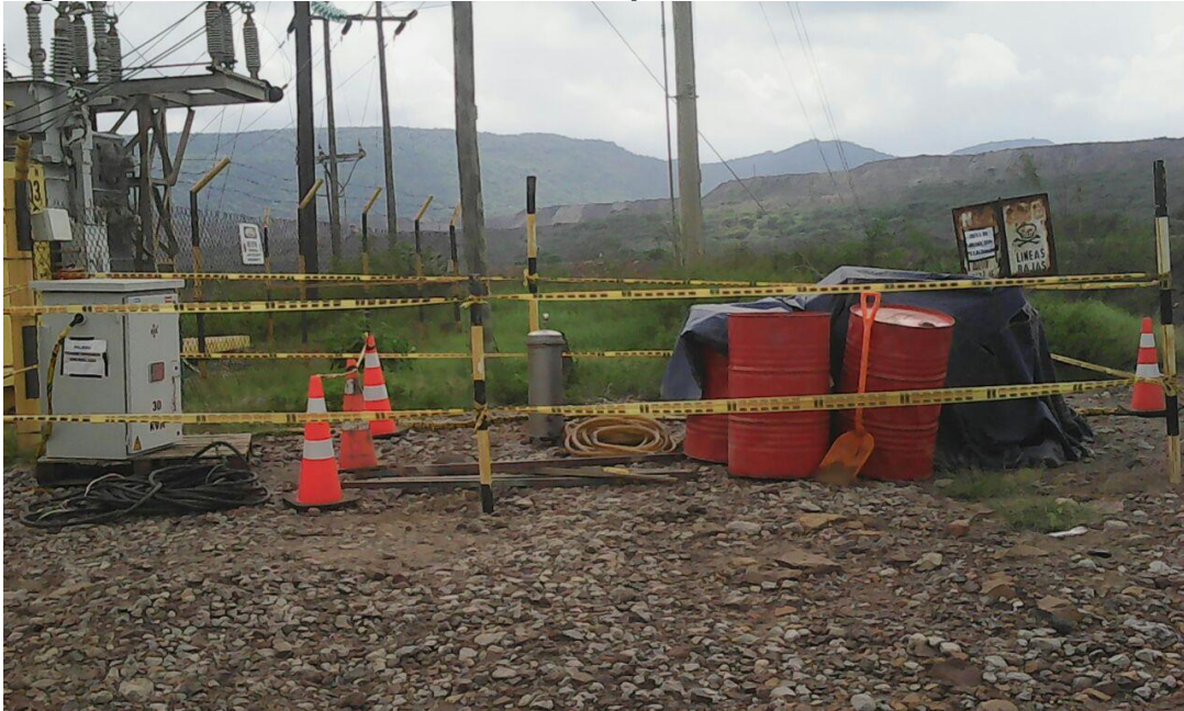
Figura 52. Delimitación de área de trabajo durante proceso de regeneración de aceite en sitio en empresa sector minero
