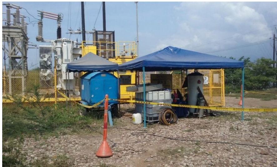
Figura 2. Imagen de proceso de regeneración de aceite en empresa del sector minero
