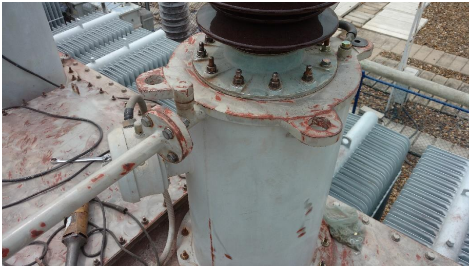
Figura 45. Preparación de superficie de la tapa del tanque principal de transformador de 100 MVA
