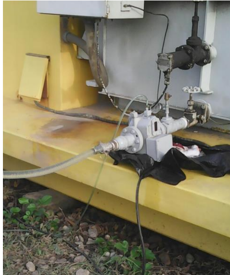
Figura 53. Instalación de relé Buchollz en la válvula inferior del transformador
