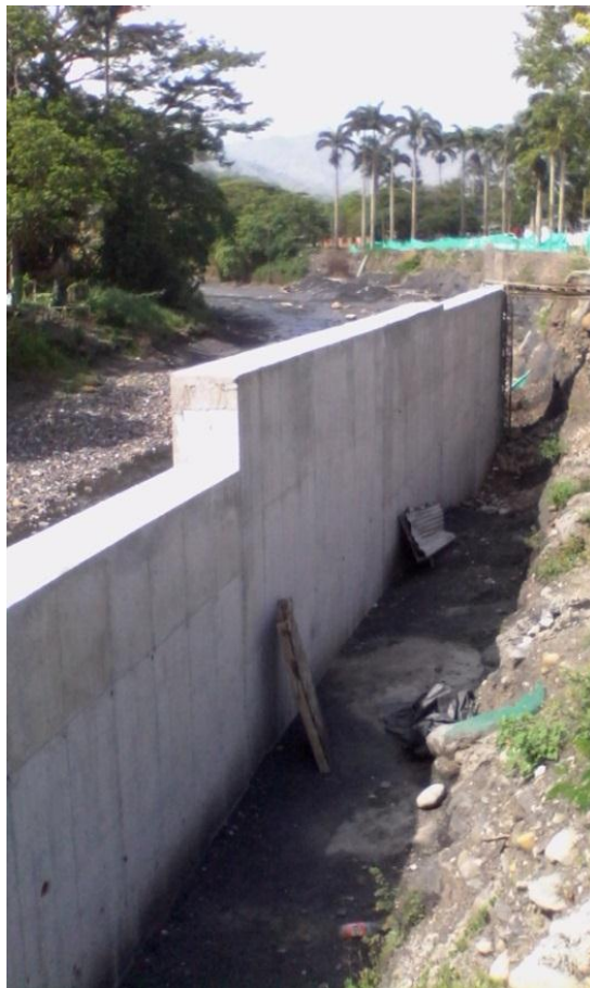
Anexo 28. Módulos 27 y 28 terminados
