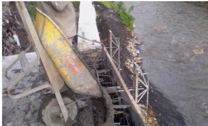
Anexo 23. Vaciado de concreto sobre cuerpo de muro.
