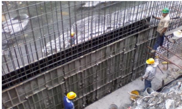
Anexo 17. Encofrado de muro armado.
