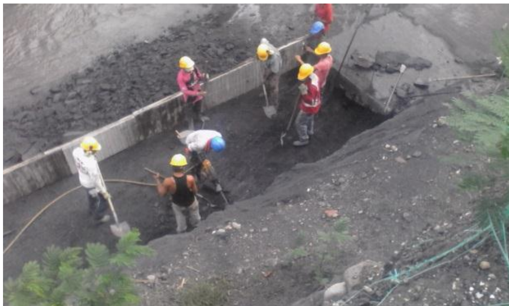
Figura 8. Excavación a mano.
