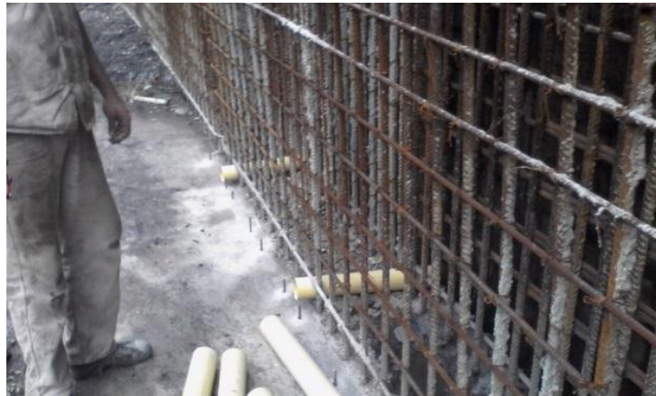
Anexo 20. Aplicación del desmoldante para la formaleta metálica del muro.
