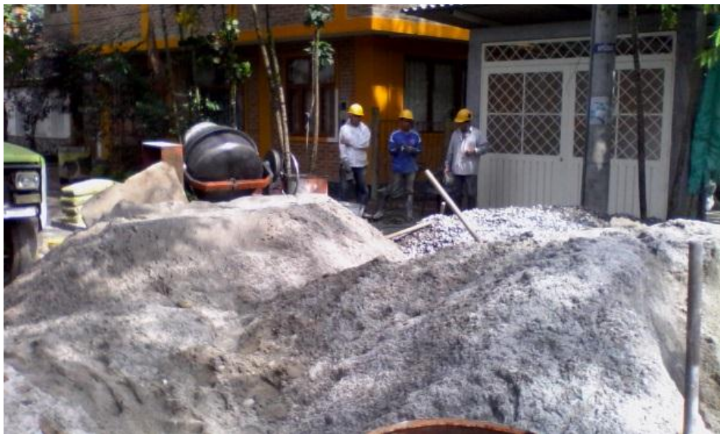
Figura 19. Zona de preparación de mezcla de concreto.
