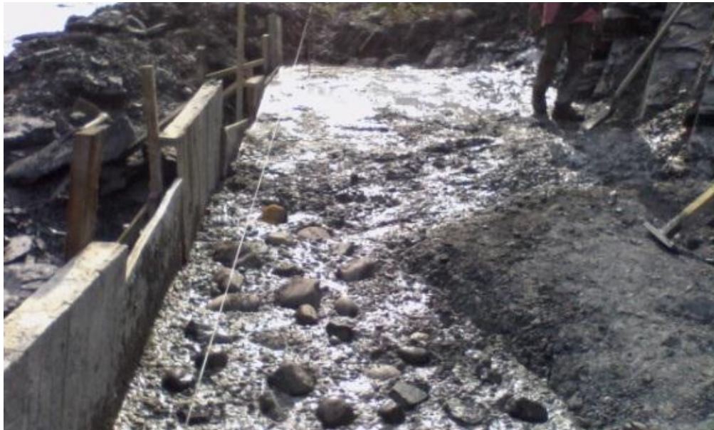
Figura 17. Concreto ciclópeo para nivelación.
