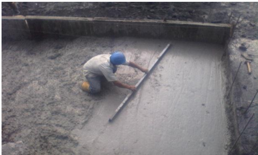
Figura 9. Solados en concreto de 13.8 [Mpa].
