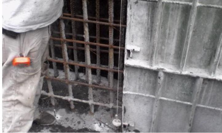
Anexo 19. Instalación de tubería PVC 3" para lloraderos embebidos en el muro.
