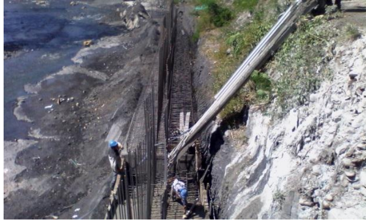
Anexo 16. Amarrado de acero cuerpo de muro.
