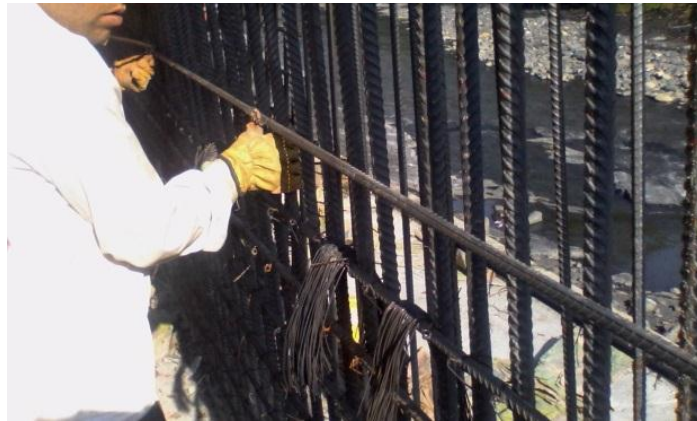
Anexo 16. Amarrado de acero cuerpo de muro.
