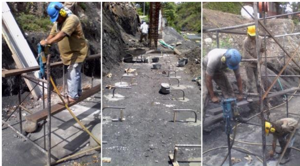
Figura 10. Perforación y anclajes de 1”.
