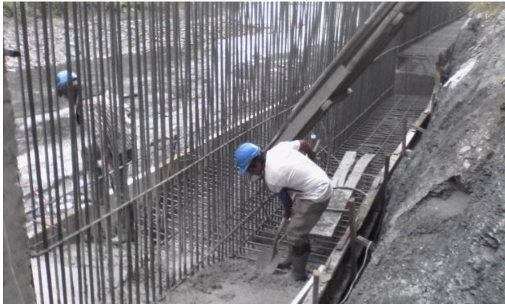
Figura 15. Vaciado del concreto en la zarpa.
