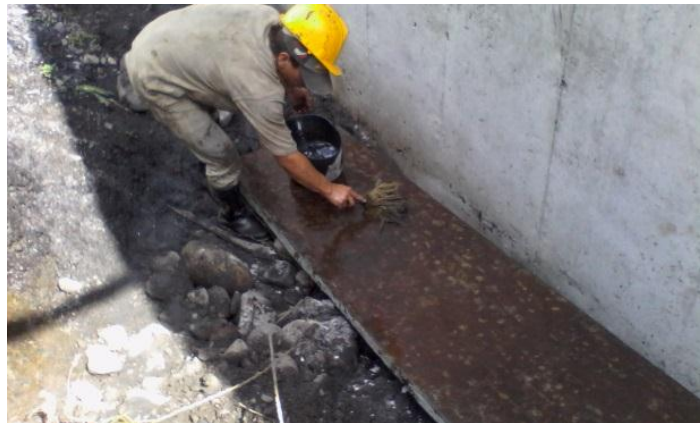
Anexo 20. Aplicación del desmoldante para la formaleta metálica del muro.
