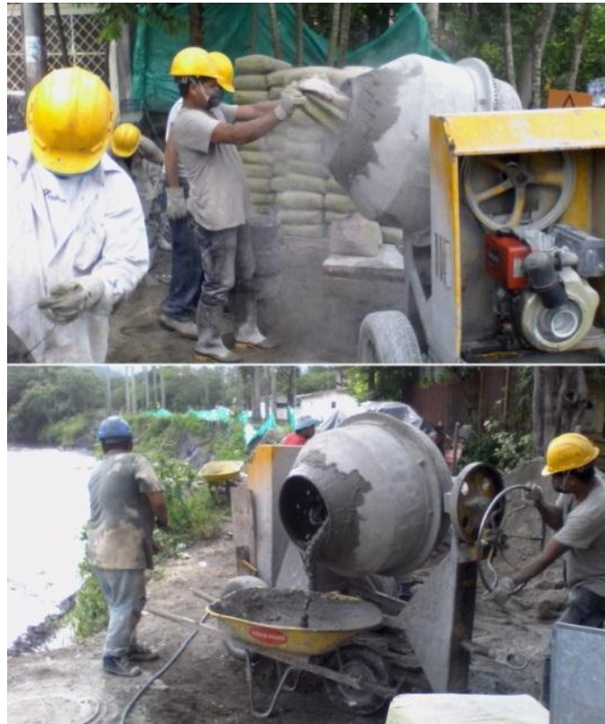
Figura 14. Preparación de concreto en obra.
