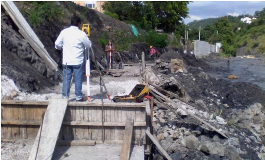
Figura 7. Topógrafo marcando la ubicación de anclajes.
