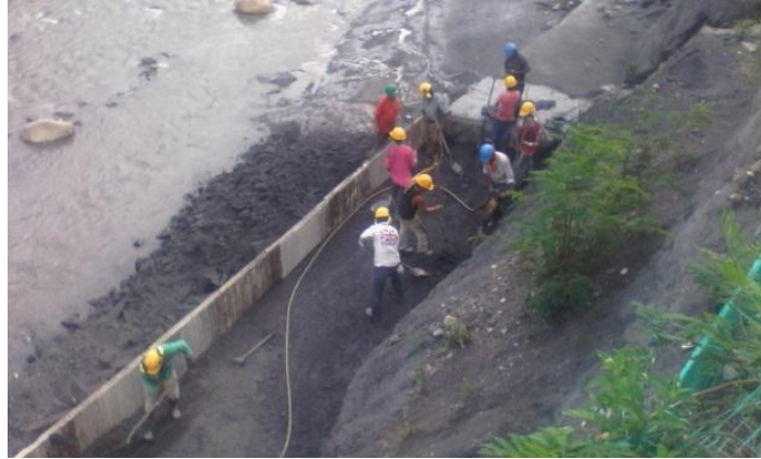
Anexo 7. Plomada de formaleta para fundir Solados en concreto ciclopeo.
