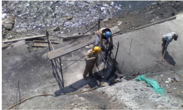
Anexo 10. Anclajes de 1” instalados sobre solado.
