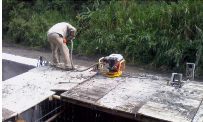
Anexo 24. Vibrado del cuerpo de muro durante su fundida.
