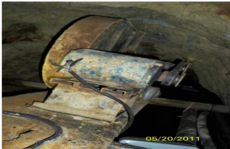
Figura 17. Instalación de sopladores de aire al interior de la mina.
