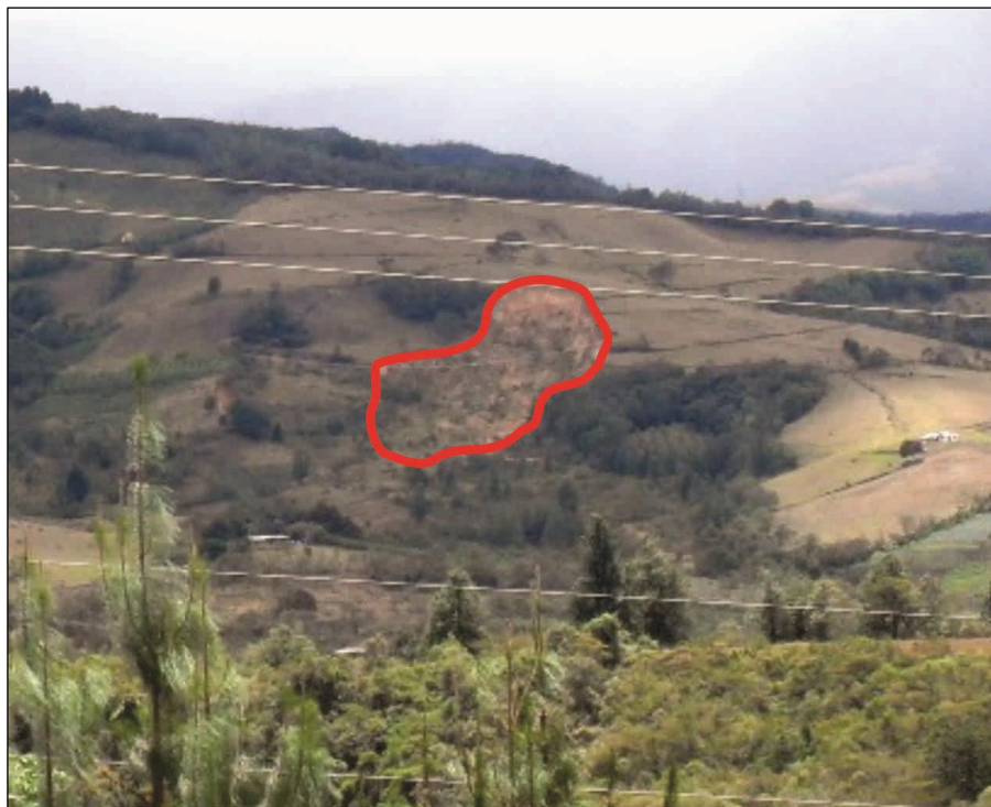
Figura 32. Deslizamiento traslacional de tierras sobre la unidad Ladera Contrapendiente (Slcp)
