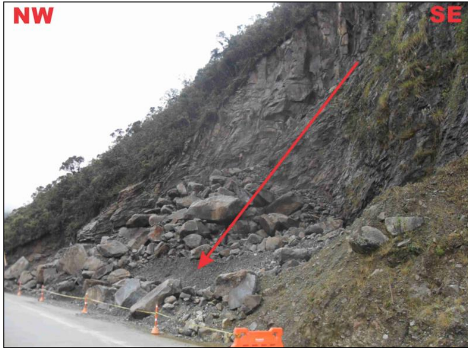
Figura 18. Caída de roca sobre la vía Gabriel López-Inza, vereda Las Margaritas.
