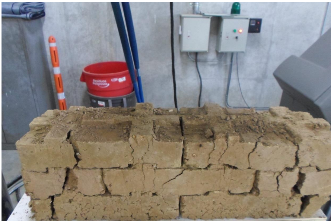
Figura 93. Tercera hilada fallada
