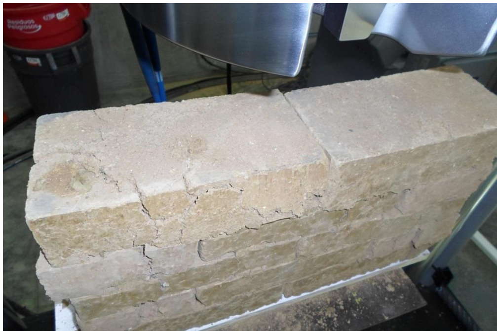
Figura 89. Vista superior murete fallado
