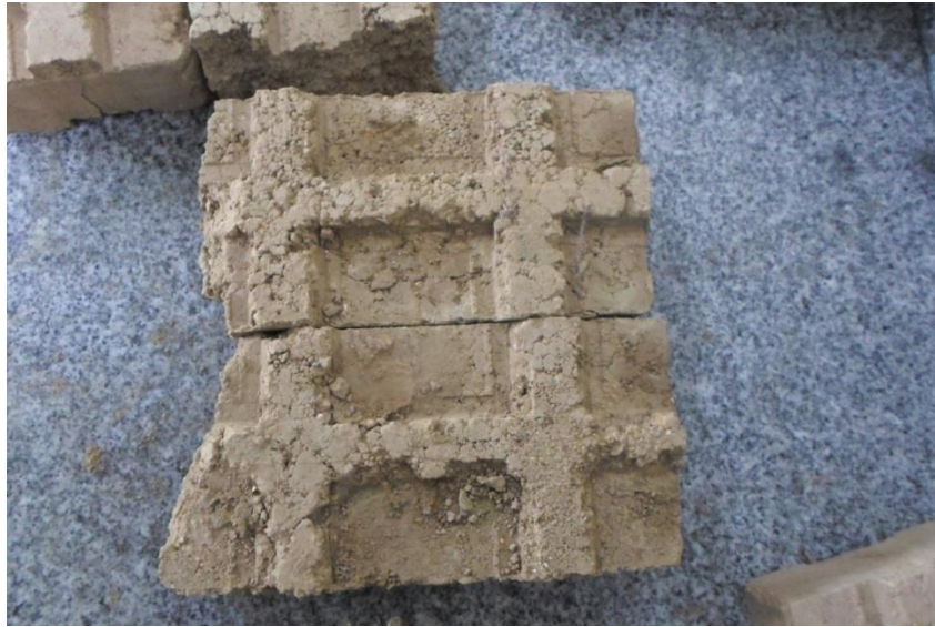
Figura 98. Detalle módulos primera hilada fallada
