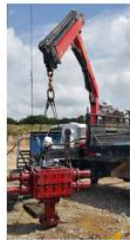
Figura 17. Comparación de la instalada de la BOP. Antes y después.
