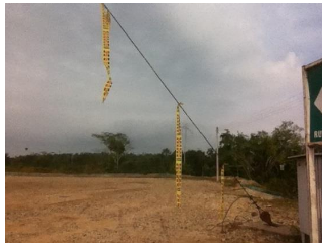
Figura 30. Señalización vientos de la torre
