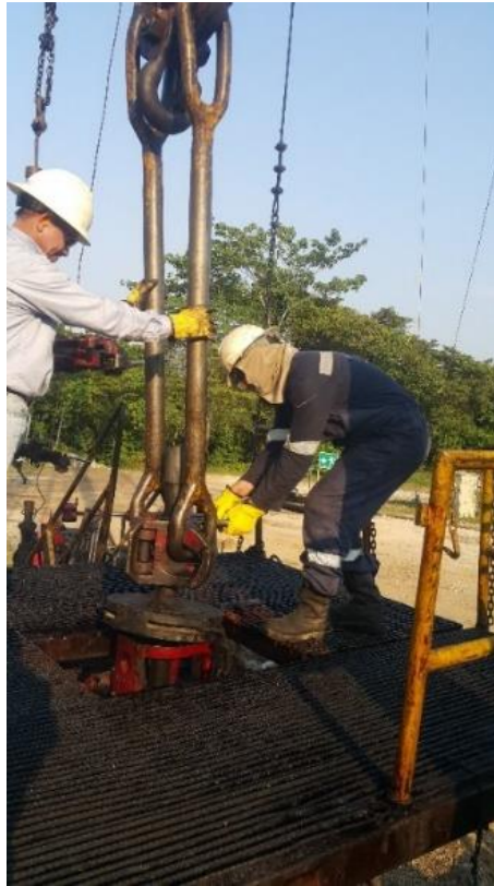
Figura 54. Debido manejo de elevador de tubería
