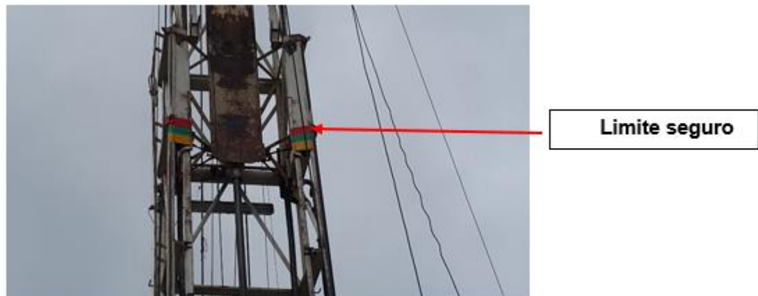
Figura 33. Marca del límite de levantamiento de la torre
