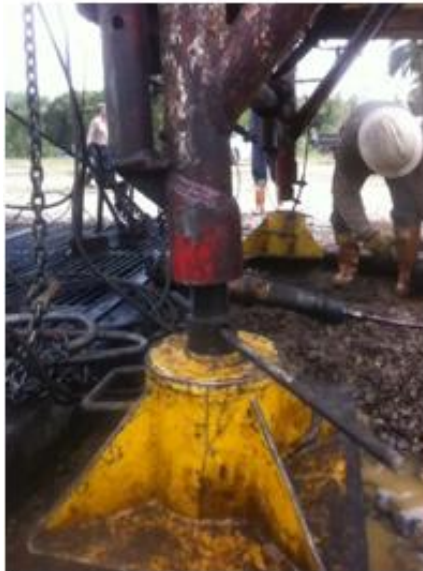
Figura 26. Tornillos mecánicos de la torre
