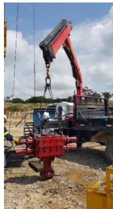
Figura 62. Levantamiento de preventora
