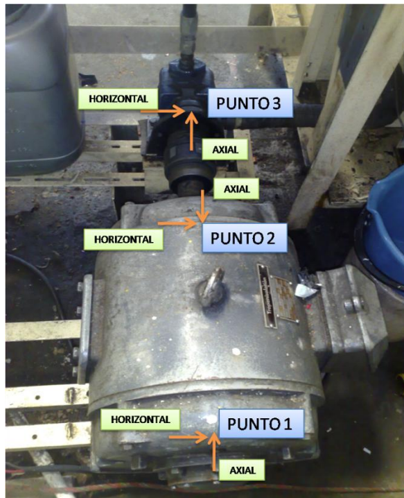
Figura 105. Sistema de bombeo 1
