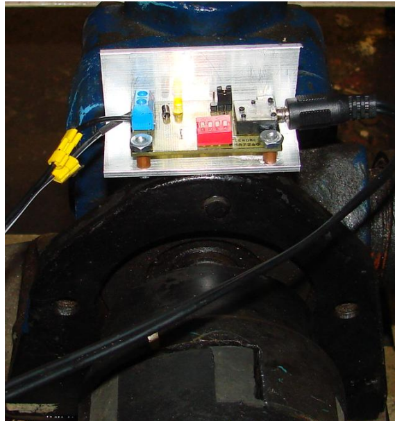
FIGURA 121 Montaje del sensor MEMS en el punto 3 Axial del sistema de bombeo 1
