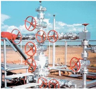
Figura 6. Árbol de Navidad de un Pozo de Petróleo.
