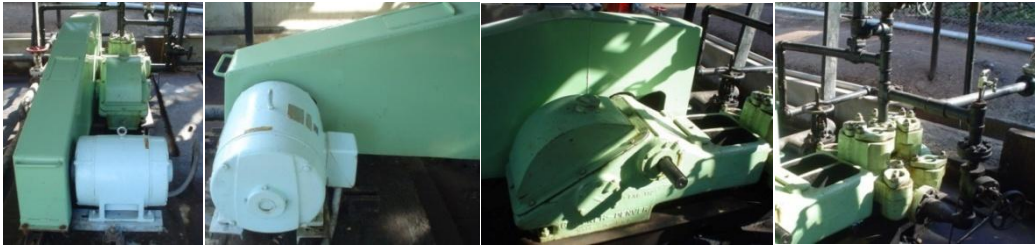
Figura 90. Conjunto Bomba Reciprocante y Motor Eléctrico para el Bombeo de Crudo de la Estación de Campo Colorado.
