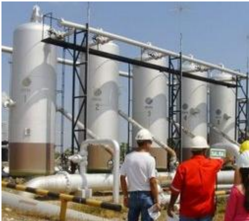
Figura 12. Instalación de Separadores Verticales de Etapa Múltiple.
