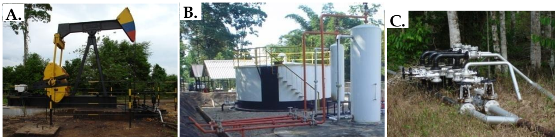
Figura 85. Infraestructura de Campo Colorado. A. Pozo Petrolero. B. Estación de Recolección y Bombeo de Crudo. C. Líneas de Tubería de Flujo.
