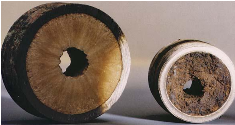
Figura 67. Disminución de Diámetro en Tubería por Problemas de Parafinas y Asfáltenos.
