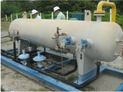
Figura 9. Separador Horizontal de Crudo.
