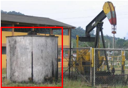
Figura 86. Tanque al lado de la Unidad de Bombeo.
