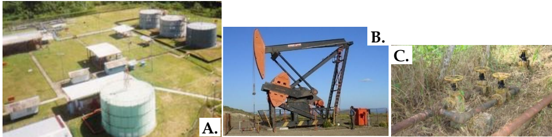
Figura 2. Infraestructura de un Campo Petrolero. A. Estación de Recolección y Bombeo de Crudo. B. Pozo Petrolero. C. Líneas de Tubería de Flujo.
