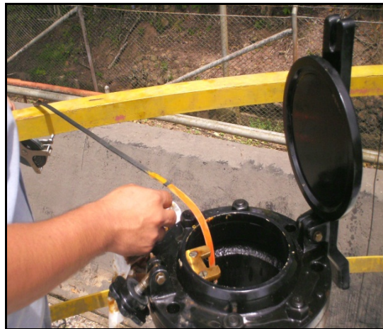
Figura 20. Medición del nivel de agua libre.
