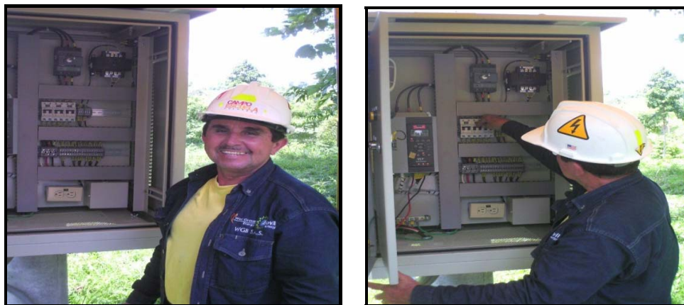
Figura 55. Variador o control eléctrico
