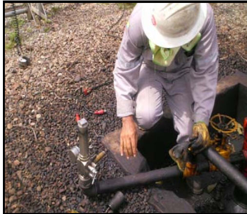
Figura 34. Conexión de la pistola de gas al pozo
