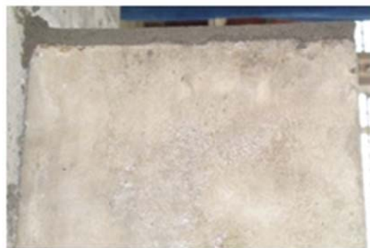
e) acabado final
