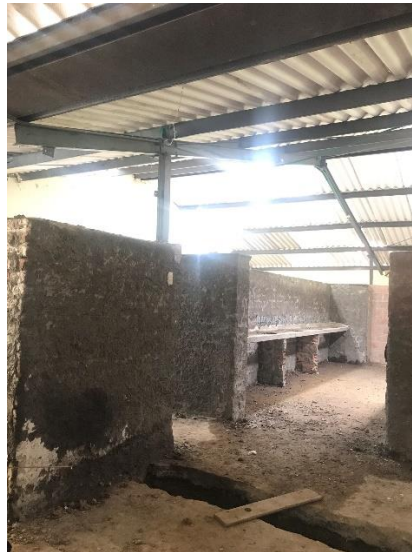
Figura 32. Excavación para cambio de tubería sanitaria
