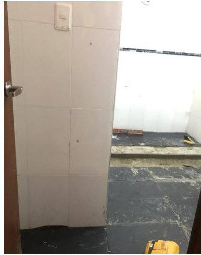
Figura 60. Instalación de porcelanato
