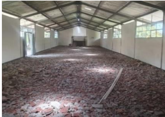
Figura 31. Actividades de demolición de enchape en alojamiento
