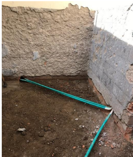
Figura 7. Arreglos e instalación de tubería y redes eléctricas
