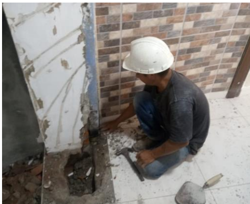
Figura 19. Bajante de aguas en tubo metálico
