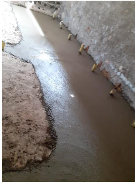
Figura 35. Fase fundición de losa concreto
