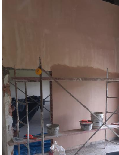
Figura 42. Levantamiento de muro
