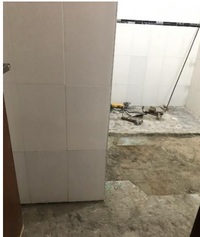
Figura 59. Demolición de enchape y desmonte de accesorios
