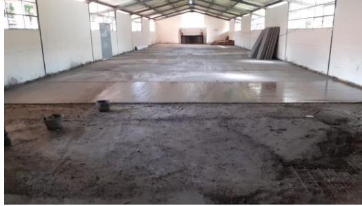
Figura 40. Aplicación de mortero de nivelación
