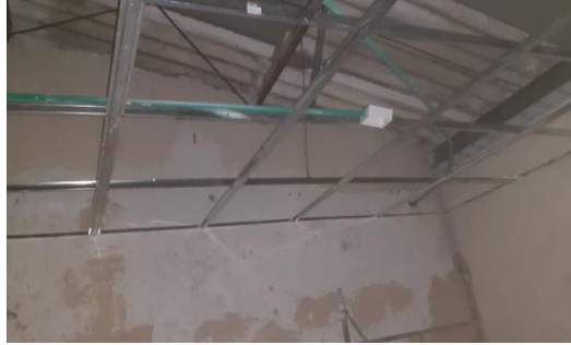
Figura 44. Instalación estructura de cielo raso en PVC
