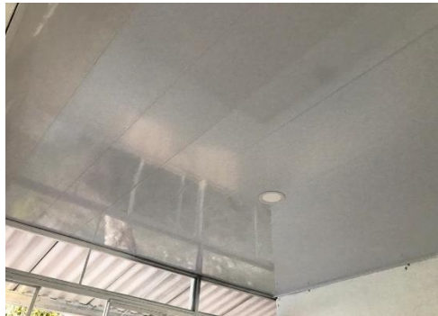
Figura 45. Instalación lámina de cielo raso en PVC
