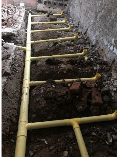
Figura 33. Instalación de red sanitaria
