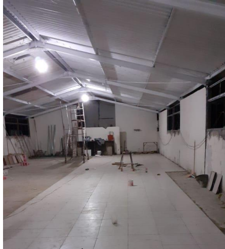
Figura 47. Fase enchape de pisos
