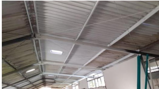
Figura 41. Mantenimiento de cubierta
