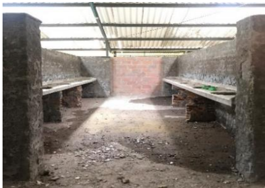
Figura 30. Actividades de demolición de enchape en batería sanitaria
