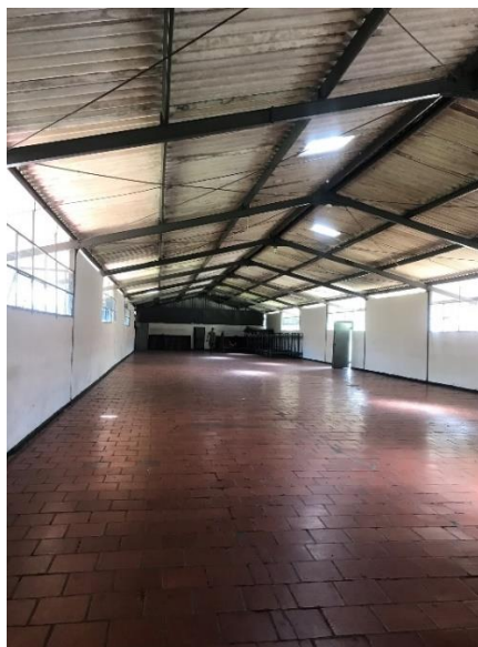
Figura 28. Alojamiento antes del mantenimiento
