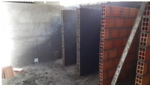
Figura 36. Construcción de divisiones de los inodoros en mampostería
