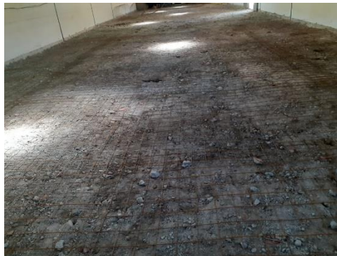
Figura 39. Instalación de maya electrosoldada
