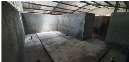
Figura 38. Pañete de muros en área de duchas
