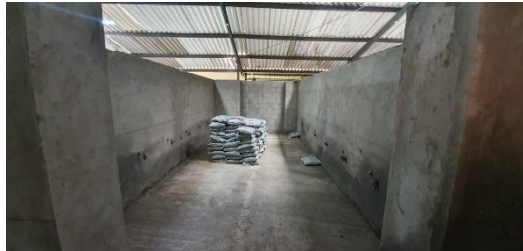
Figura 37. Pañete de muros en área de lavamanos
