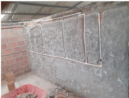
Figura 34. Instalación red hidráulica área duchas
