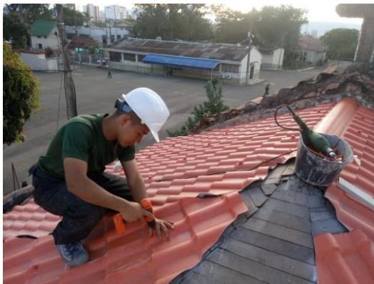
Figura 15. Instalación teja colonial en PVC
