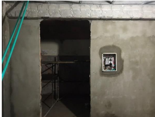
Figura 8. Mortero de nivelación y pañete de muros
