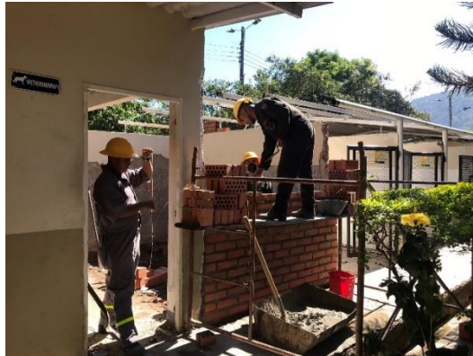
Figura 6. Construcción de muros
