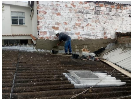
Figura 11. Cubierta antigua e impermeabilización de muros
