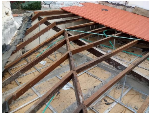
Figura 14. Estructura de la cubierta
