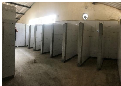
Figura 46. Fase enchape de muros
