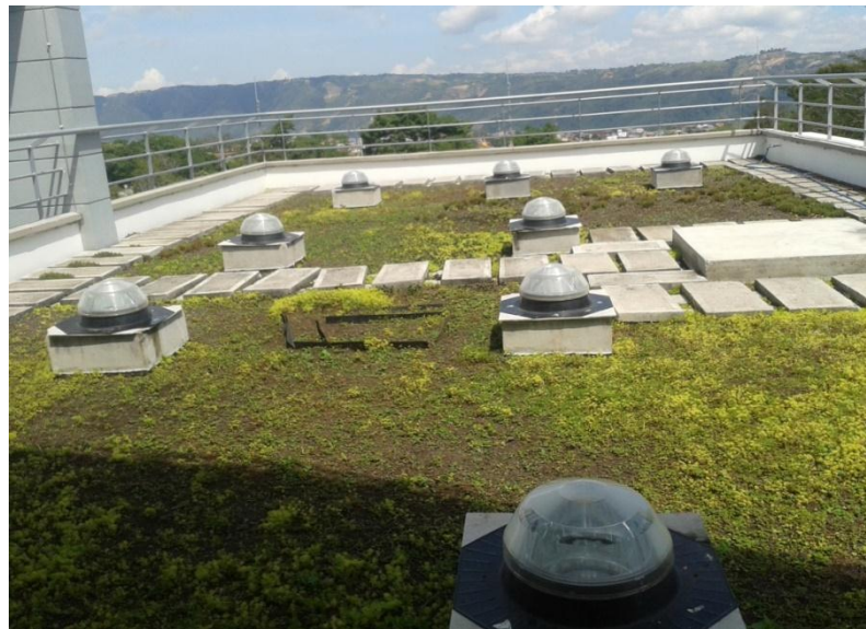
Ilustración 4. Cubierta Verde del Complejo de la E3T
