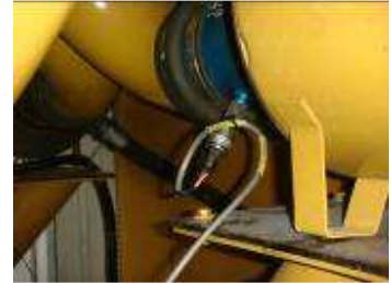
Figura 23 Sensor de Vacío Filtro Izq.
