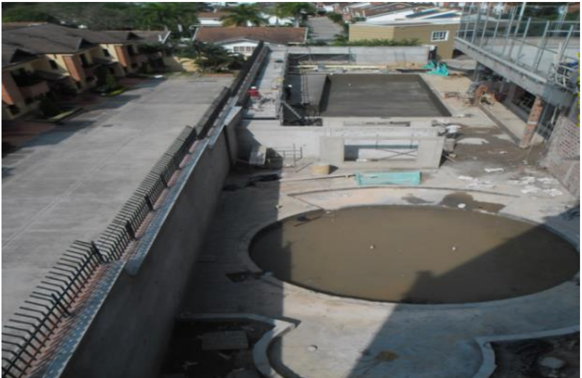
Figura 11. Estructura finalizada de las piscinas.
