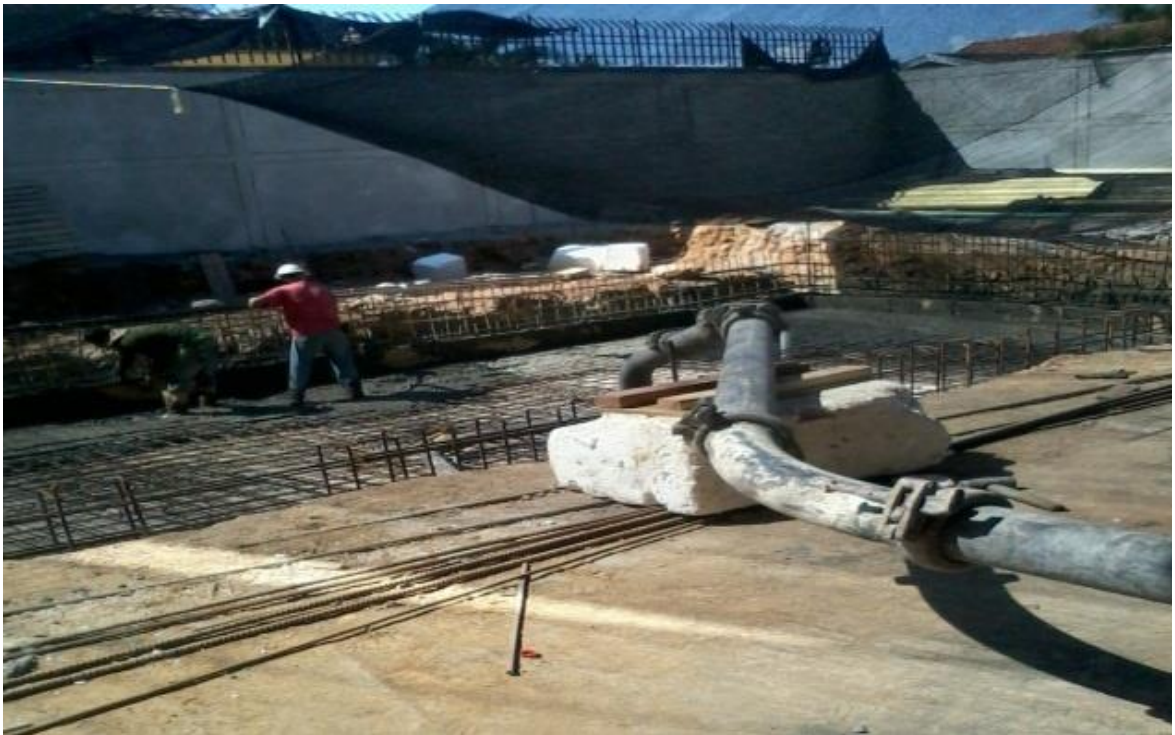
Figura 10. Armada de aceros y fundida de piscina
