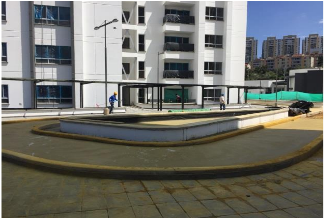
Figura 14. Triciclodromo con placas internas fundidas antes del corte de las dilataciones.
