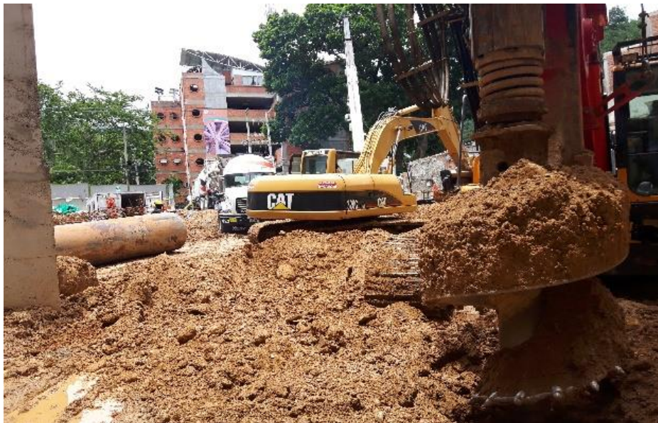
Figura 19. Broca helicoidal dentada
