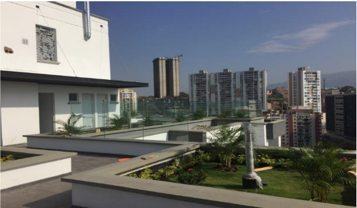
Figura 9. Elemento terminado que requirió prueba de estanqueidad, jardinera piso 19
