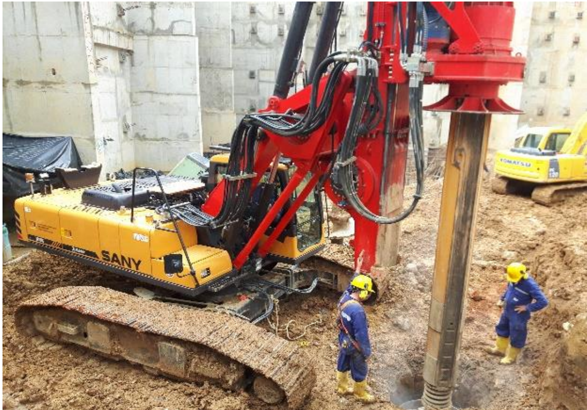
Figura 17. Pilotaje en la obra Casa 40
