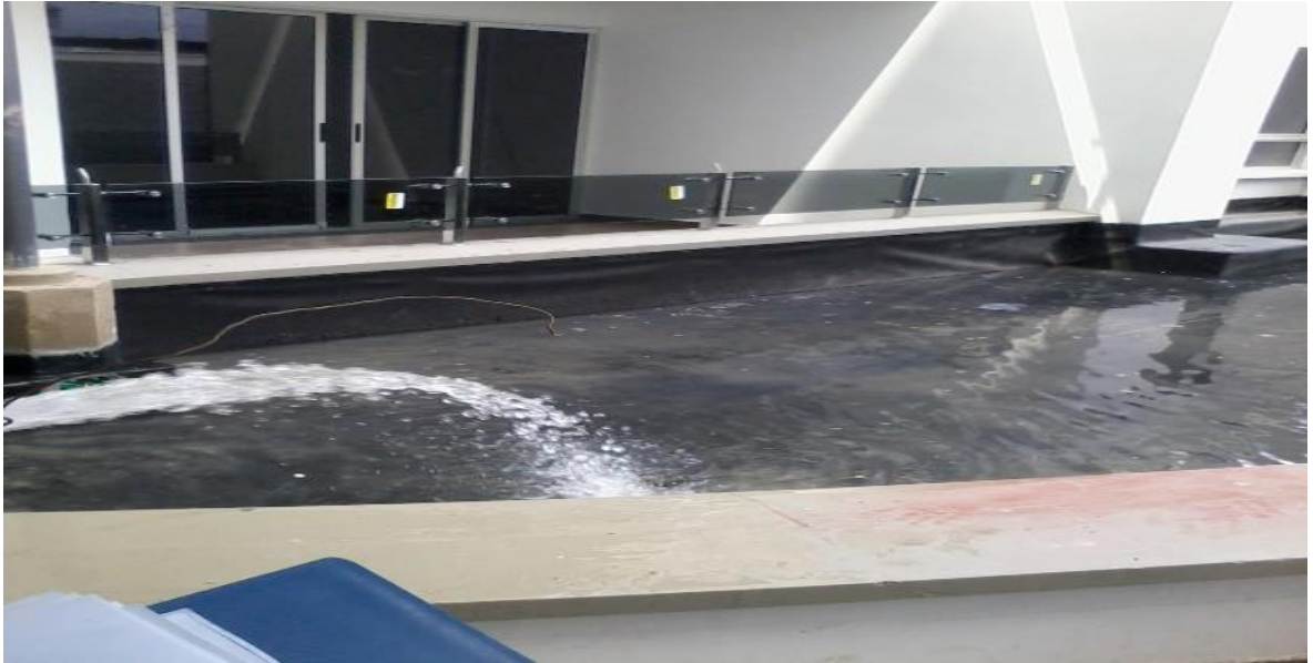
Figura 8. Llenado de jardinera primer piso.
